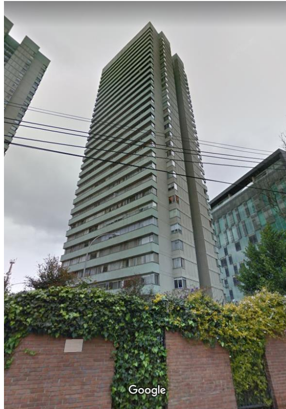
Figura 36. Estructura de concreto reforzado de 31 niveles.
