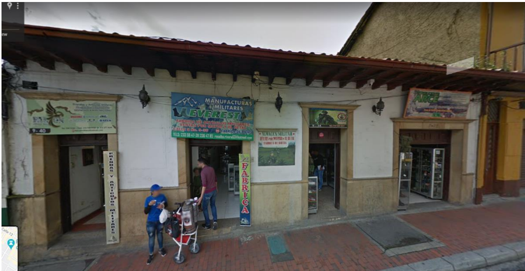
Figura 35. Estructura de mampostería estructural con material adobe.
