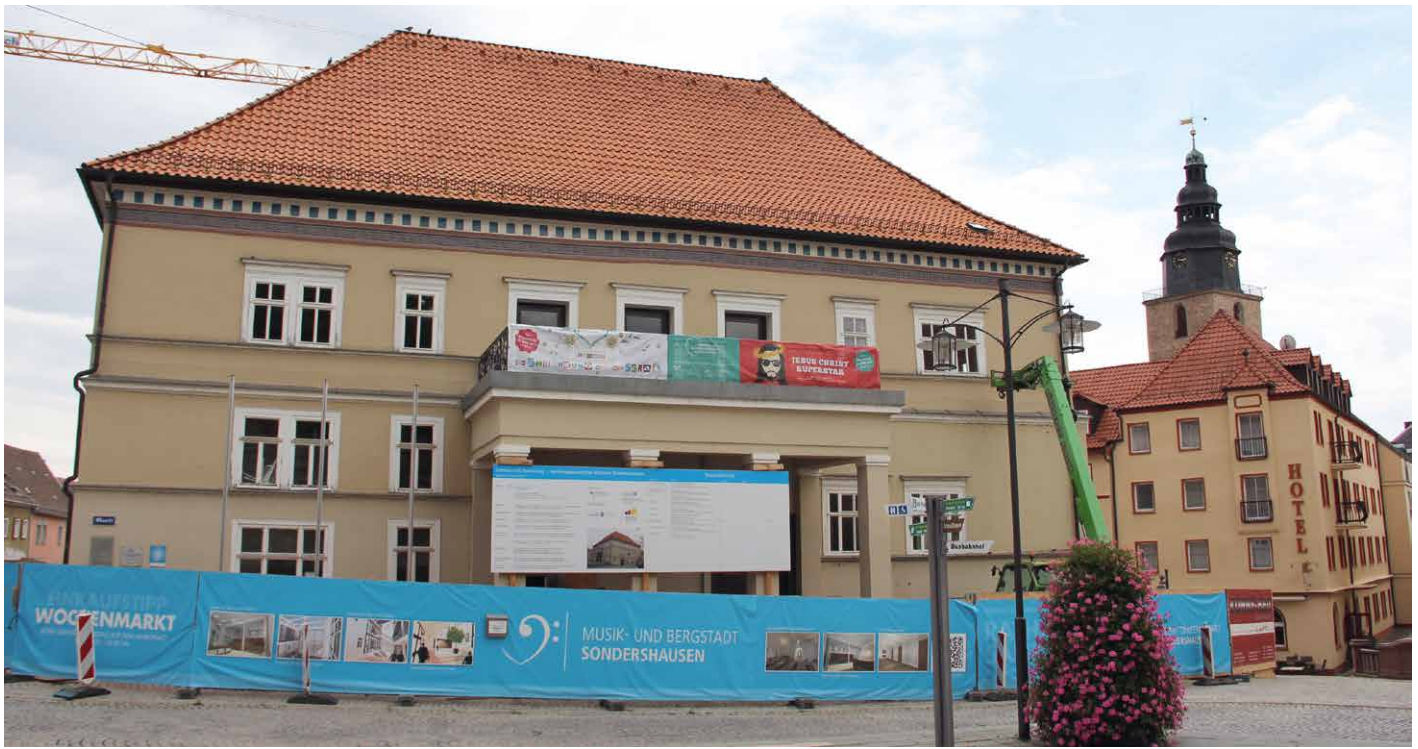
Abbildung 24: Baustelle Rathaus (Foto: Martin Graffenberger)
