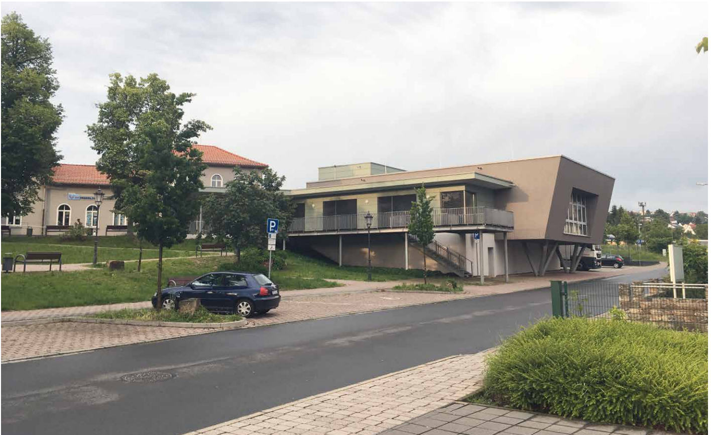
Abbildung 15: Bürgerinnen- und Bürgerzentrum am Bahnhof (Foto: Franziska Görmar)
