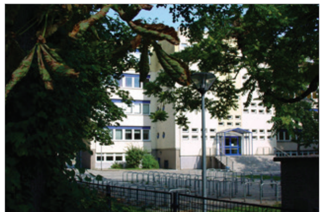
Abb. 5: Bestandsgebäude, Eingangsseite. Blick von der Krugstege
