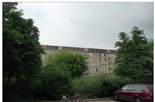
Abb. 13: Südliche Grenze des Wettbewerbsgrundstück. Angrenzend ein Spielplatz, dahinter ein DDR-Plattenwohnungsbau als bauliche Fassung
