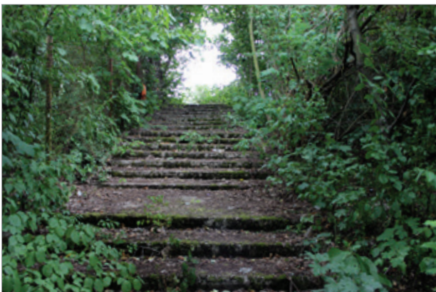
Abb. 12: Treppenverbindung von der Ebene 3 auf die Ebene 4 (ehemaliger Sportplatz) am nördlichen Grundstücksrand mit Blick nach Osten
