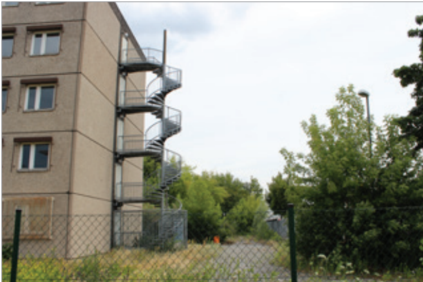
Abb. 8: Blick nach Osten auf nördliches Wettbewerbsgrundstück, im Vordergrund westliche Wettbewerbsgrenze links Büroplattenbau, der abgerissen wird
