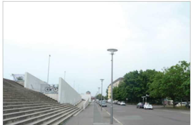
Abb. 9: Blick entlang der Ernst-Riedel-Straße nach Süden, rechts das Wettbewerbsgrundstück, links die Rampenanlage auf das Hochplateau des Velodroms
