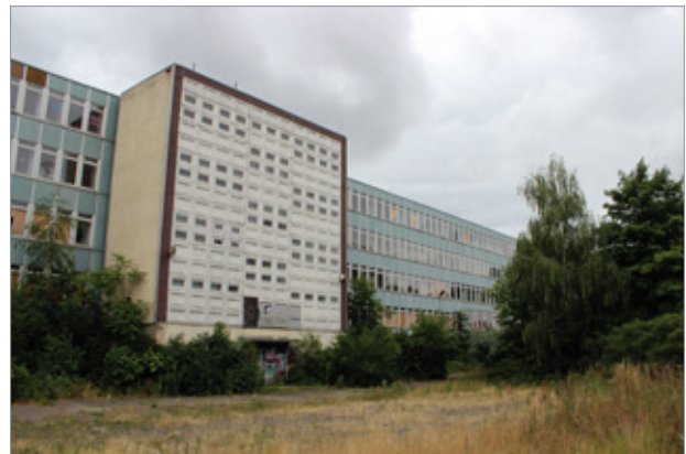
Abb. 5: Ebene 1 (Straßenniveau), Blick nach Südwesten auf das Bestandsschulgebäude, das abgerissen wird
