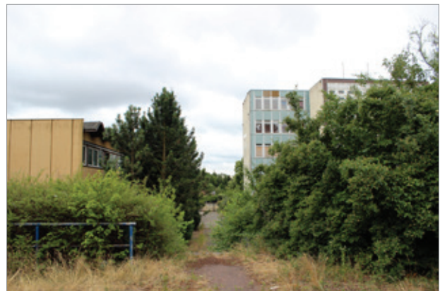
Abb. 7: Blick von Ebene 2 nach Süden, links Bestands-sporthalle, rechts Bestandsschulbau, die beide abgerissen werden, im Hintergrund Eisenstraße
