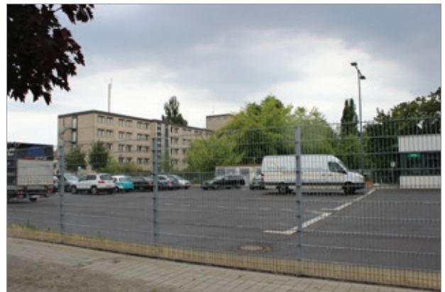
Abb. 11: Blick nach Südwesten über Parkplatz der Dekra, der nicht Teil des Wettbewerbsgebiet ist, im Hintergrund Büroplattenbau auf Wettbewerbsgrundstück, der abgerissen wird
