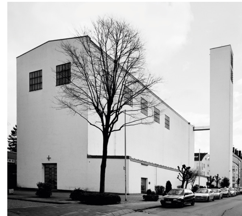
1. Aachen, St. Fronleichnam. Außenaufnahme der Südwestseite, um 1930. Foto: Jürgen Gregori, LVR-Amt für Denkmalpflege im Rheinland (LVR-ADR), 2006.
