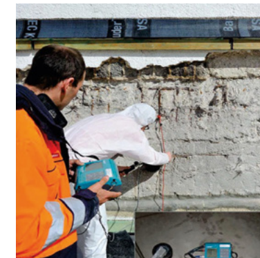
7. St. Fronleichnam, Potentialfeldmessung am Betonskelett. Archiv Hahn Helten + Thiemann Bauleitungs GmbH, Aachen.
