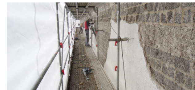
8. St. Fronleichnam, Fassade nach Entfernung des zu harten Putzes. Archiv Hahn Helten + Thiemann Bauleitungs GmbH, Aachen.
