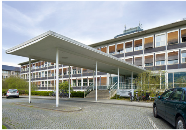
6. Krefeld, Stadthaus. Außenansicht von Süden. Foto: Silvia Margrit Wolf, LVR-ADR, 2016.
