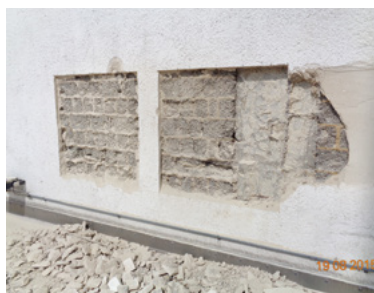
6. St. Fronleichnam, Korrosionsschäden im Bereich des Überzuges und an den Knotenpunkten der Tragstruktur. Archiv Hahn Helten + Thiemann Bauleitungs GmbH, Aachen.
