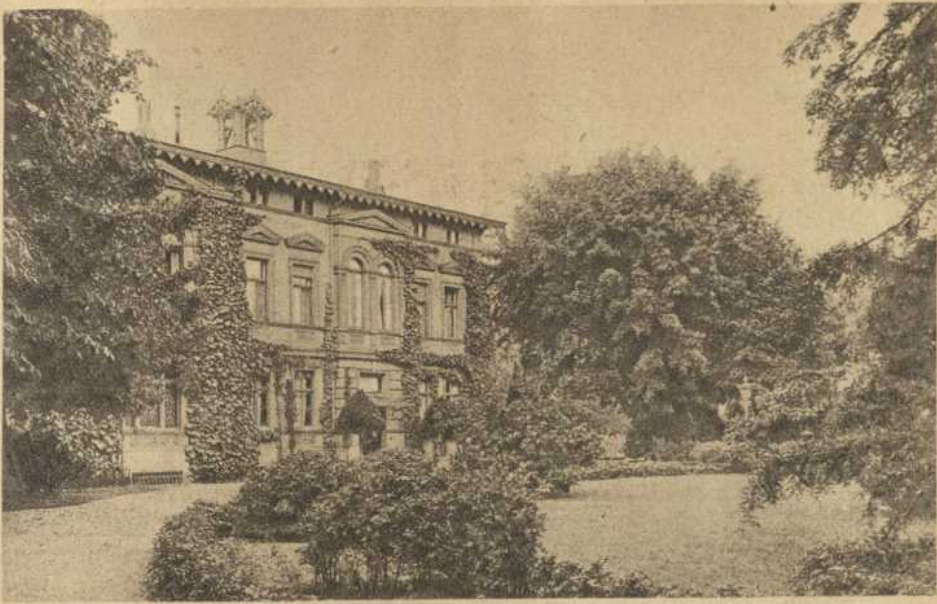
Das von Franz Späth erbaute Wohnhaus in Berlin-Baumschulenweg.
