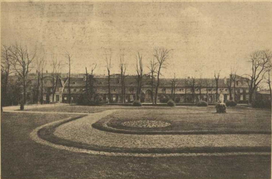
Gebäude der Hofgärtnerei im Schlosspark Charlottenburg, wo Carl Friedrich Späth der Aeltere während seiner Lehrzeit mehrere Jahre wohnte.
