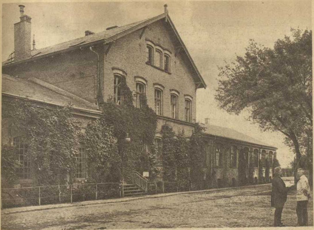
Bürogebäude in Baumschulenweg.
