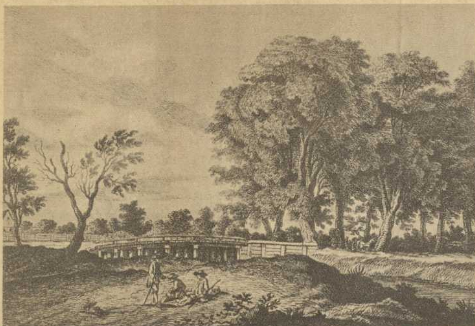
Die Schaaf-Brücke vor dem Potsdamer Tor im Jahre 1775. Die heutige Potsdamer Brücke.
