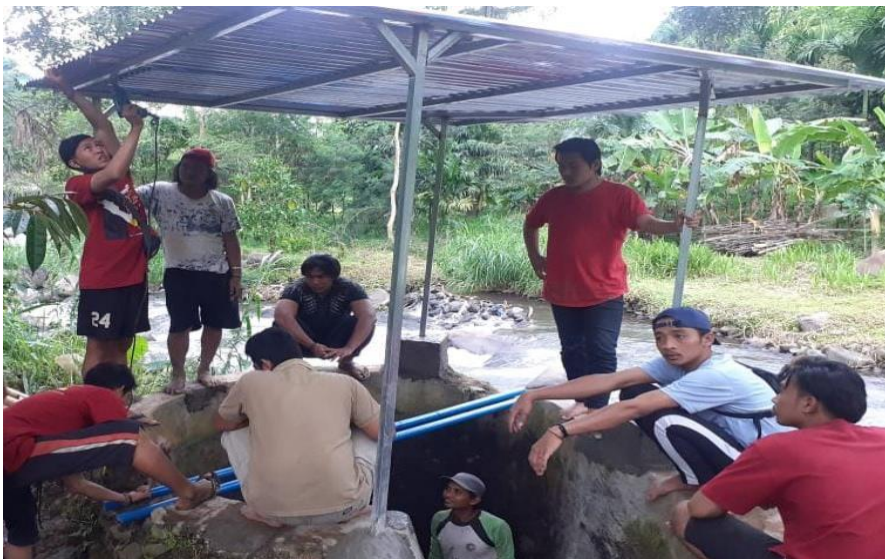
Gambar 2. Pemasangan Atap Vortex
