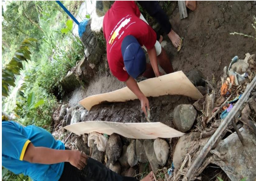
Gambar 5. Perbaikan Saluran Irigasi
