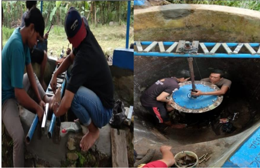
Gambar 3. Pemasangan As penyangga turbin Vortex dan Turbin Vortex
