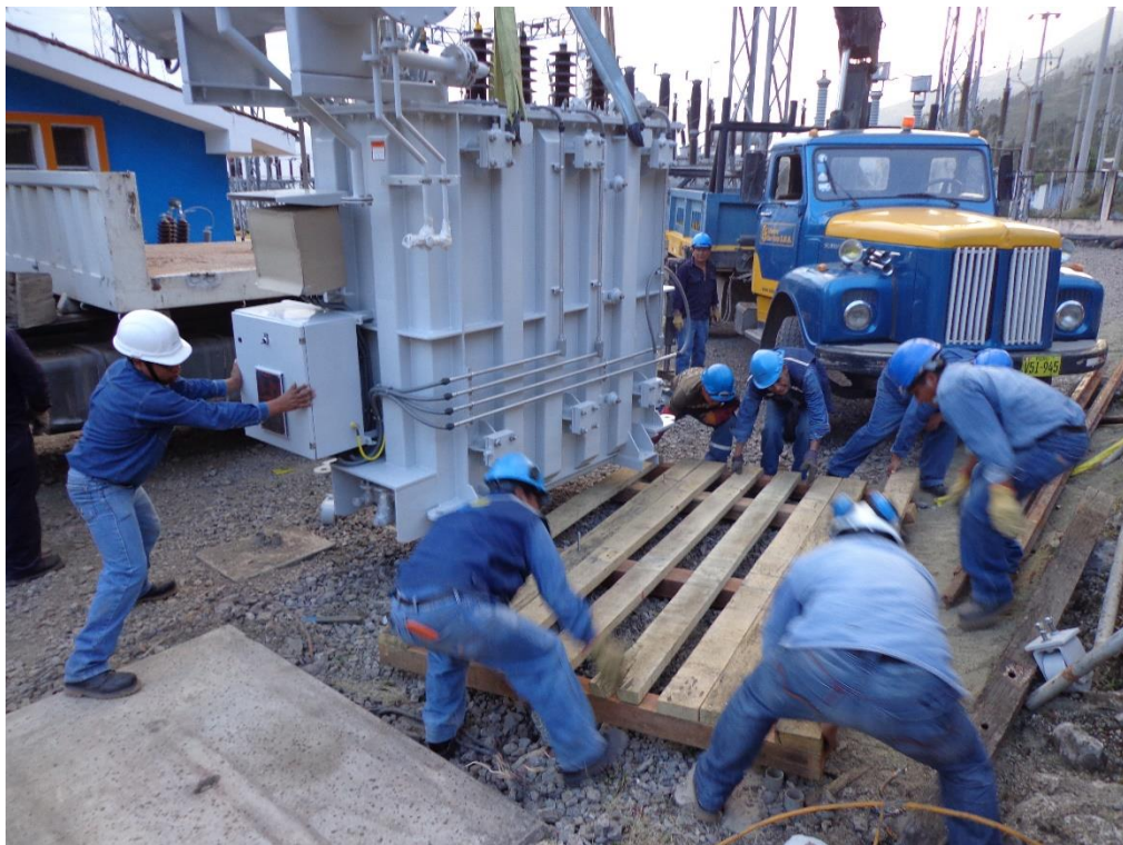
Figura 8: Descenso del transformador nuevo para su instalación.
