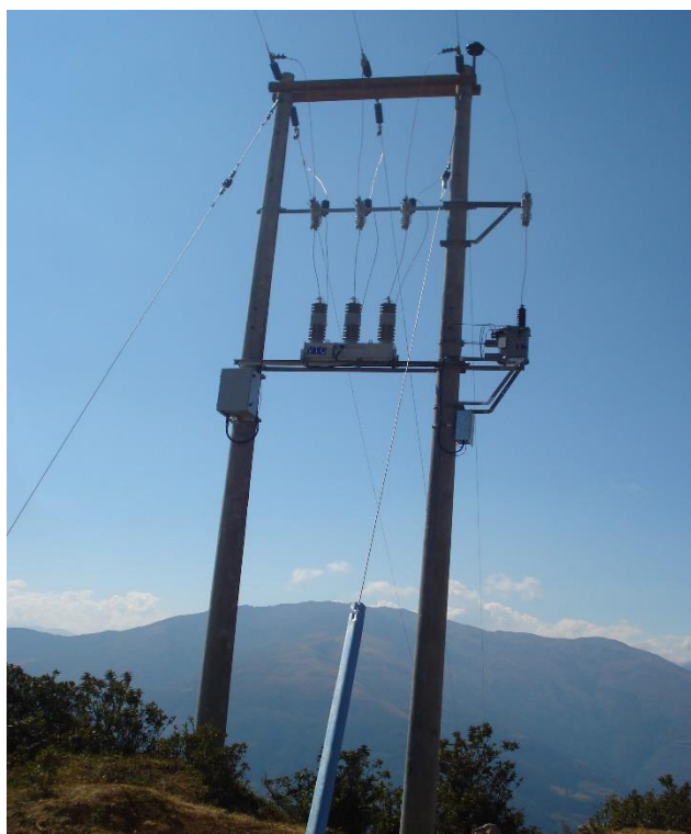
Figura 2: Instalación de Recloser en la derivación hacia Cachora.
