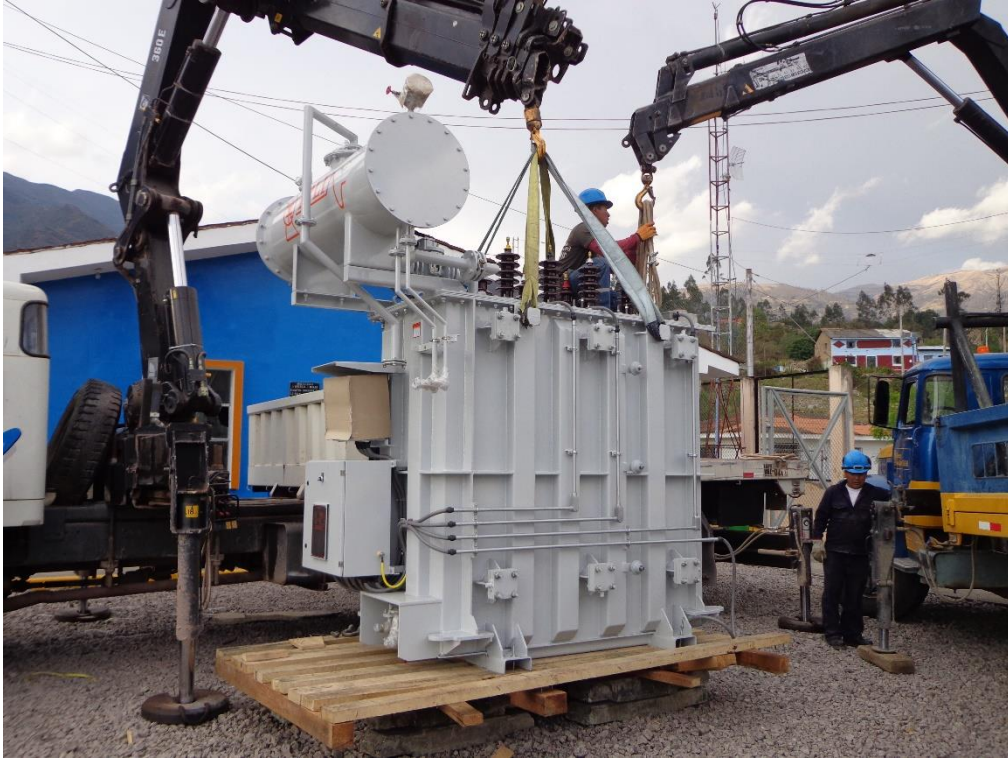
Figura 3: Transporte de transformador nuevo de 5MVA para el alimentador TA-05
