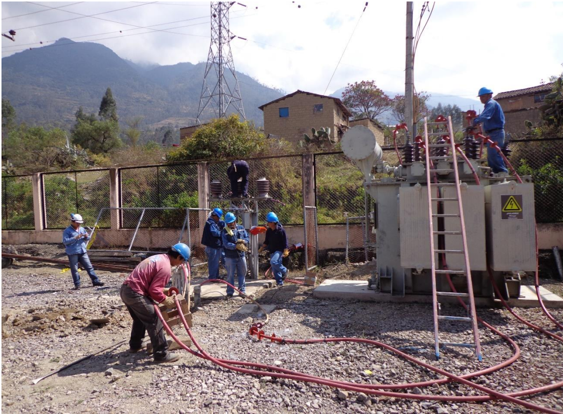
Figura 13: Preparación de conexionado del transformador nuevo
