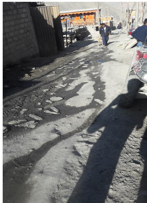
Fotografía 18. Eliminación de agua con metales pesados y sin tratamiento previo, a las calles de la ciudad de Secocha
