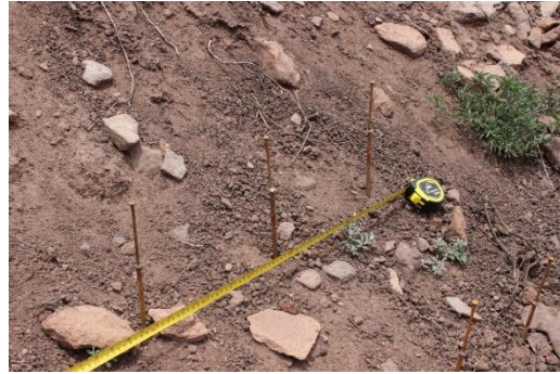
Foto 10: Instalación de los clavos para erosión
