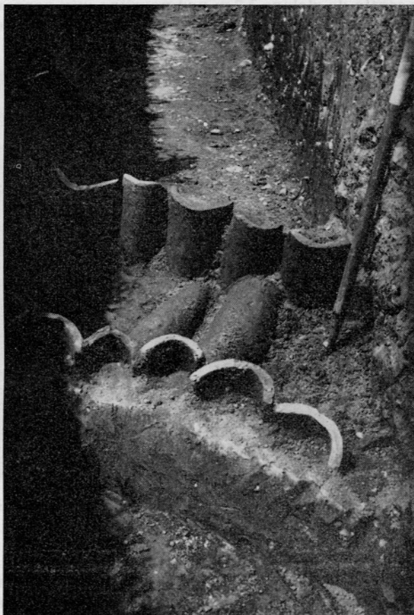
Slika 1. Iz imbreksov zgrajeni odprti kanal (?) v vzhodnem delu izkopišča Fig. 1. Canal ouvert construit en imbriquées dans la partie est des fouilles
