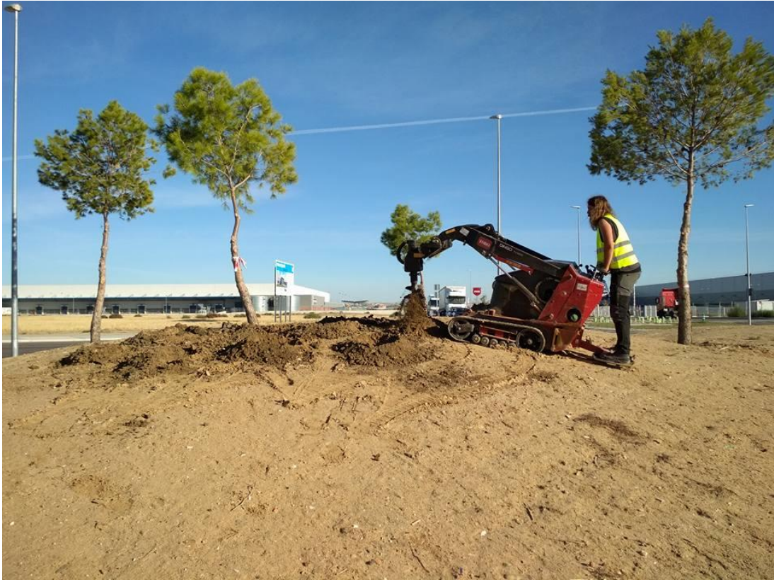
Figura 32. Uso del Toro con acople de ahoyadora de barrena de 40cm para elaborar los agujeros en la rotonda.
