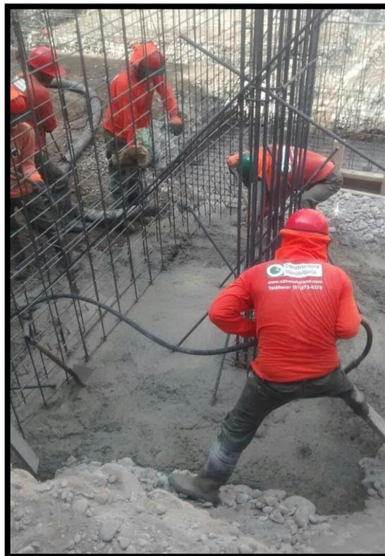
*Figura N° 39: Vertido de Concreto para zapata.*
