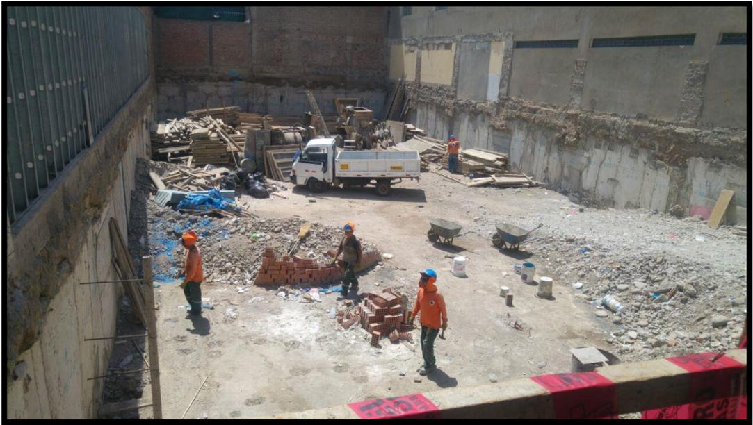
*Figura N° 31: Acarreo de materiales a punto de Acopio.*
