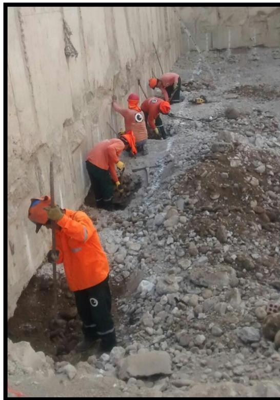
*Figura N° 30: Excavación manual para calzaduras.*
