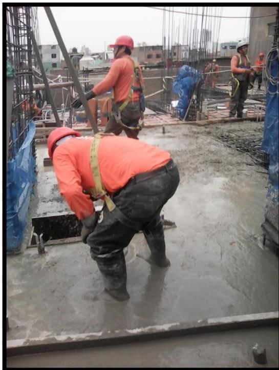
*Figura N° 48: Acabado tipo frotachado en losa.*
