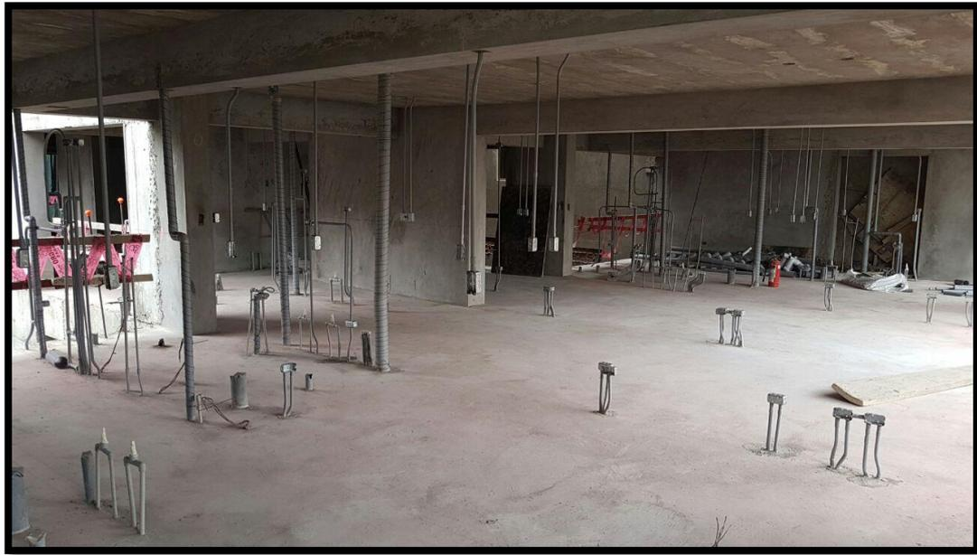
*Figura N° 60: Salidas de Desagüe y agua.*
