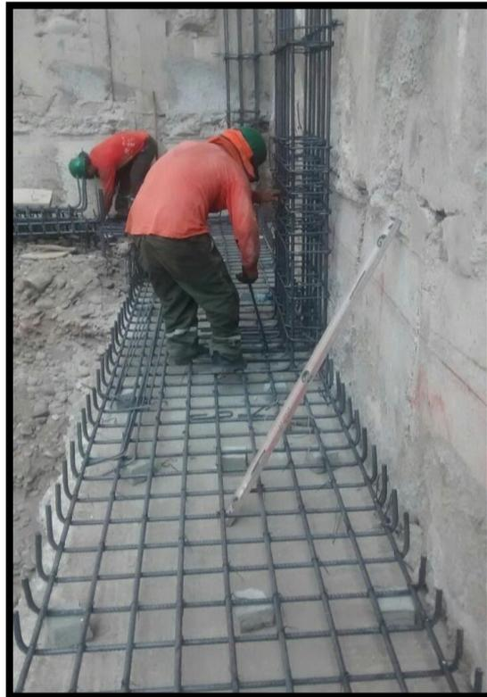
*Figura N° 35: Armadura de Acero para Cimiento reforzado.*
