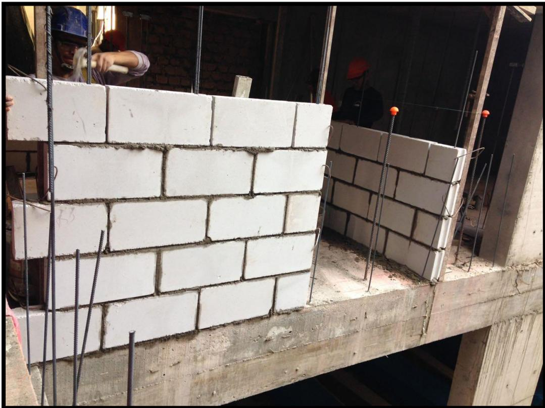
*Figura N° 53: Asentado de Ladrillo Silico Calcáreo P10.*
