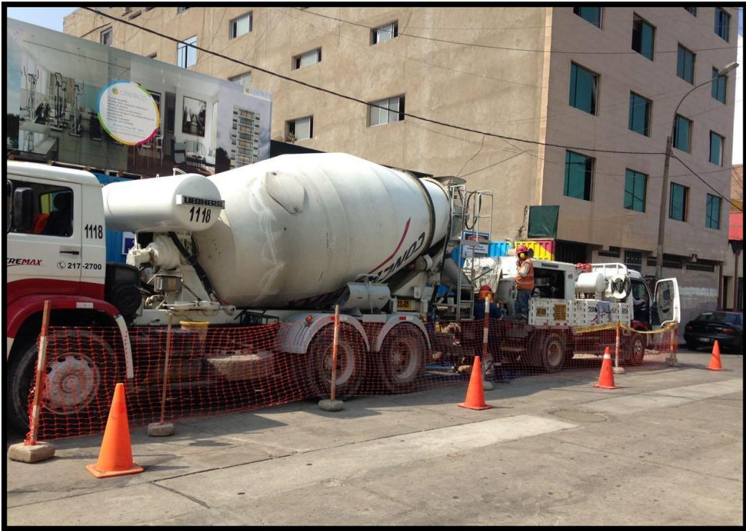
*Figura N° 38: Vertido de Concreto de Mixer a bomba estacionaria.*
