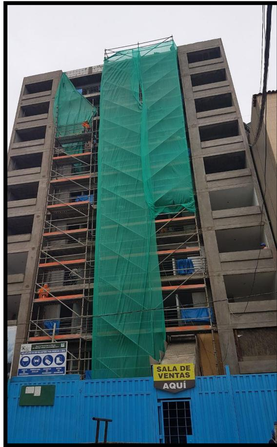
*Figura N° 64: Tarrajeo de Fachada de Edificio Centrico.*
