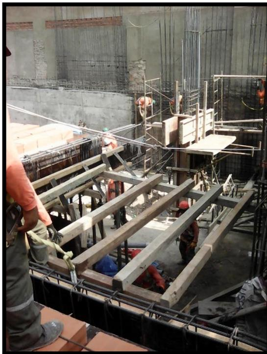
*Figura N° 40: Armado de Soleras para encofrado.*
