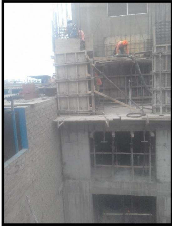
*Figura N° 49: Vertido de Concreto en Columna.*
