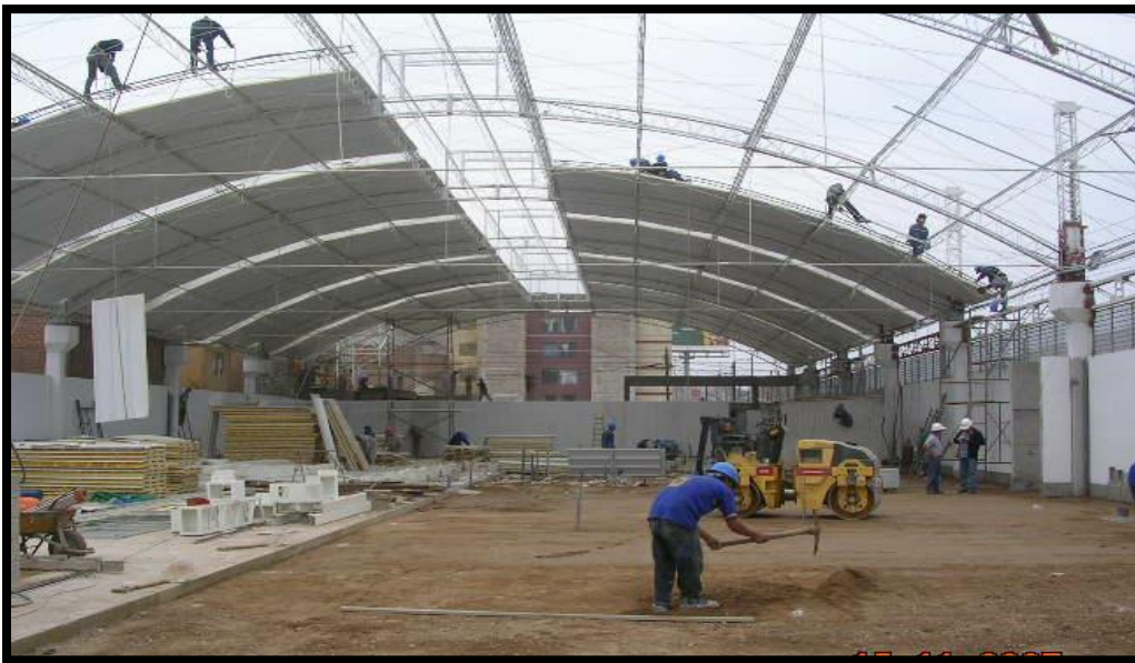
Fotografía 14. Instalación de la cobertura liviana con aislante térmico.
