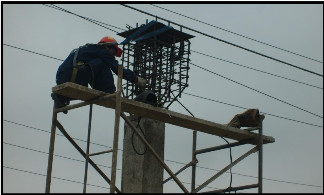
Fotografía 8. Planchas de anclaje en los cabezales de las columnas.
