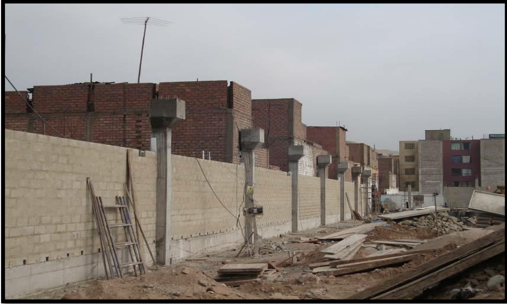
Fotografía 9. Columnas de concreto con cabezales para recibir arco metálico.
