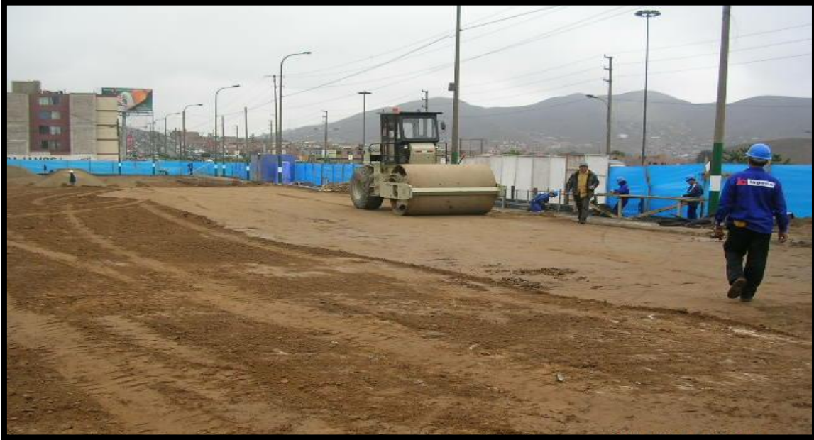
Fotografía 1. Nivelación y compactación de terreno con material de préstamo
