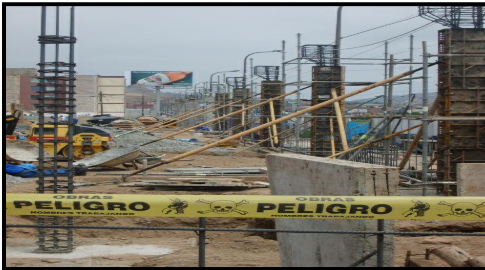
Fotografía 6. Encofrado de columnas con paneles metálicos.
