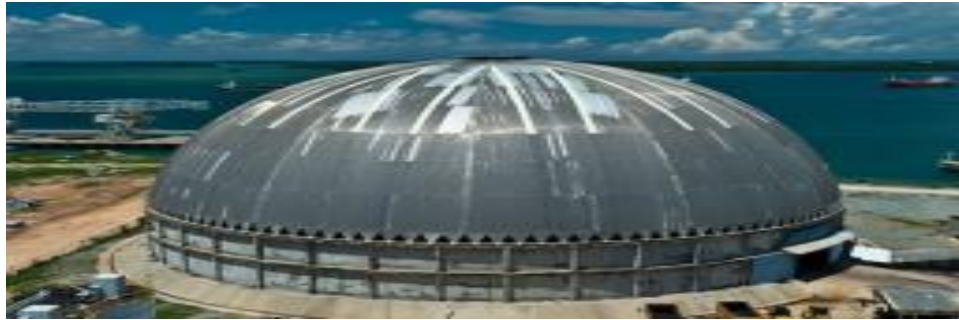
Figura 12. Techo tipo domo o cascarón en proceso constructivo.
