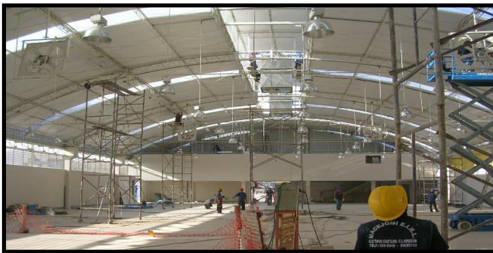
Fotografía 16. Terminado de la cobertura e instalación de luminarias.
