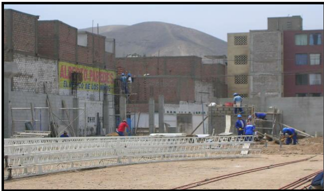
Fotografía 10. Arcos metálicos para conformación de cobertura.
