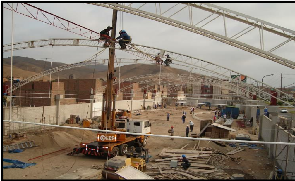
Fotografía 11. Montaje de arcos metálicos y vegetas de amarre.
