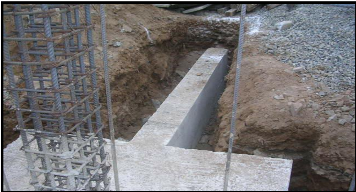
Fotografía 2. Zapata excéntrica y viga conectora.
