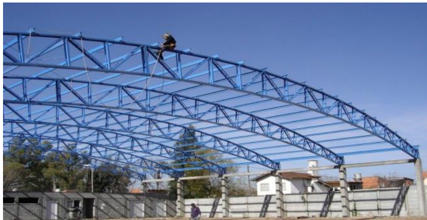
Figura 8. Techo parabólico en proceso constructivo.
