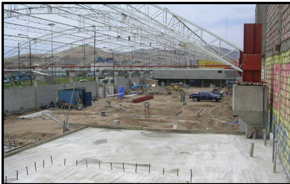
Fotografía 12. Vista de estructura metálica concluida.
