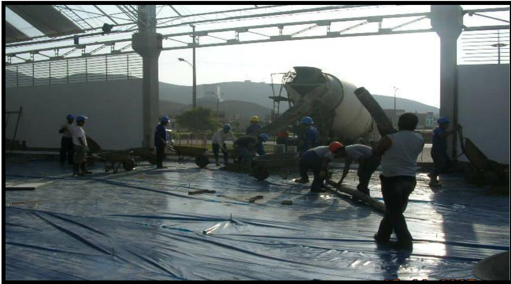
Fotografía 15. Colocación de concreto premezclado para piso.
