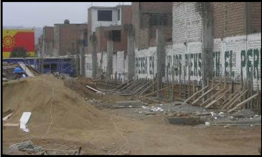
Fotografía 7. Encofrado de sobrecimiento para muros perimetrales.
