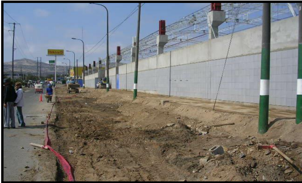
Fotografía 13. Vista exterior de la nave metálica.
