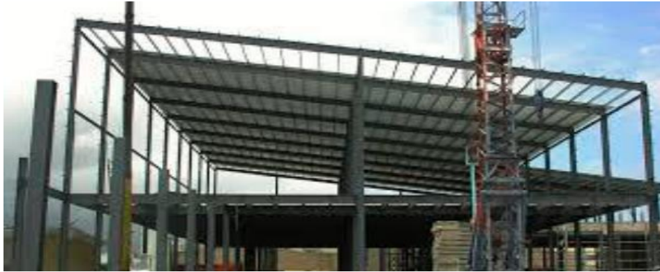
Figura 10. Techo a un agua con pendiente moderada.
