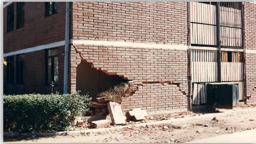
Figura 3. Muro no reforzado
