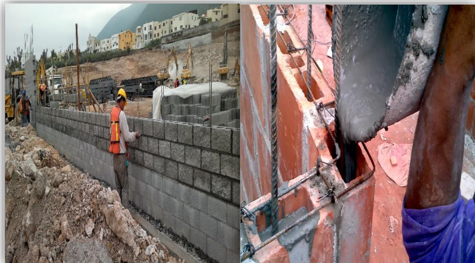
Figura 4. Muro de albañilería armada
