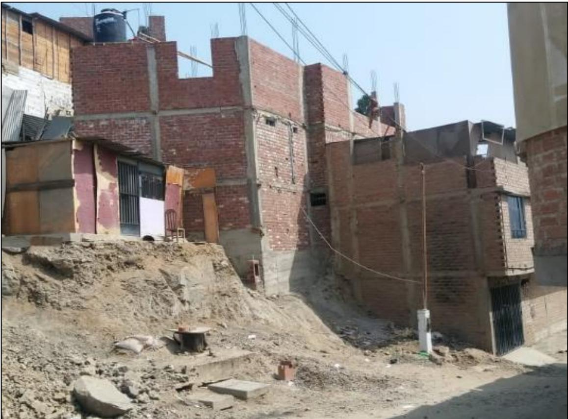
*Imagen 6: se evidencia las construcciones son irregulares no existe simetría en la estructura*
