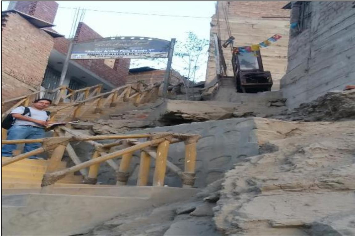
*Imagen 3: Pasaje "y" se aprecia las viviendas no tienen bases sólidas y no cuenta con zapatas*
