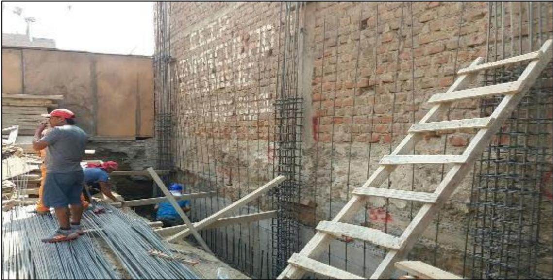
*Figura 17: Armado de zapatas y columnas*
