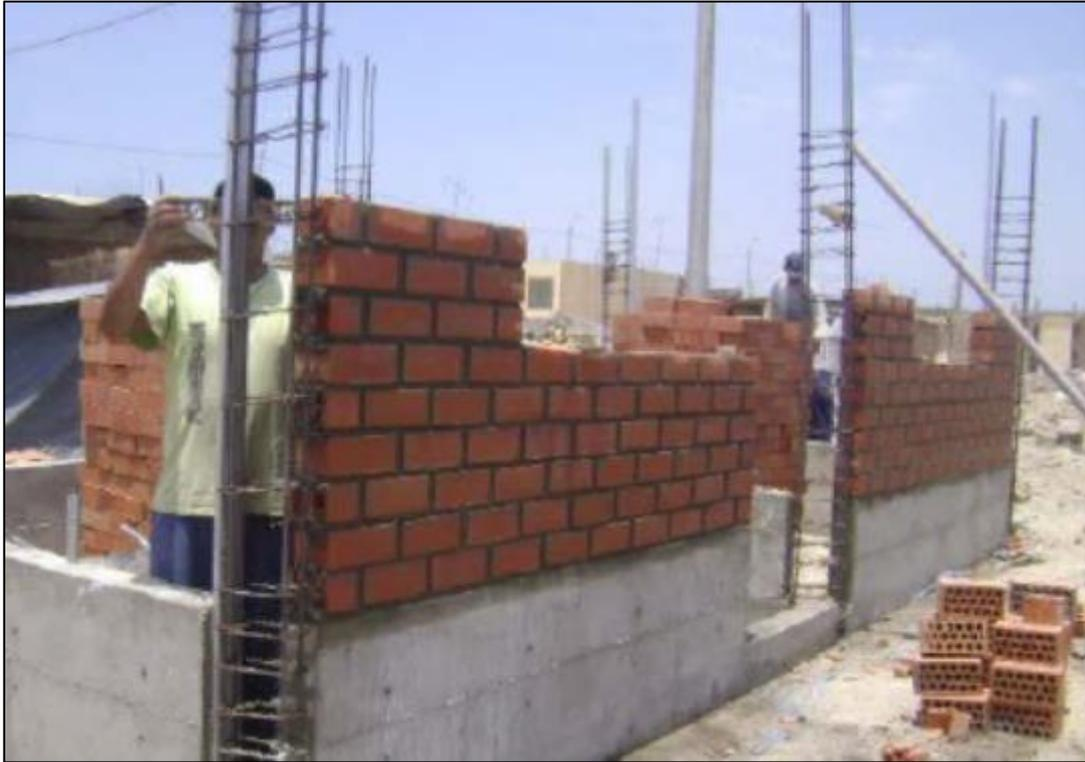
*Figura 18: Asentado de ladrillo y colocación de columnas*
