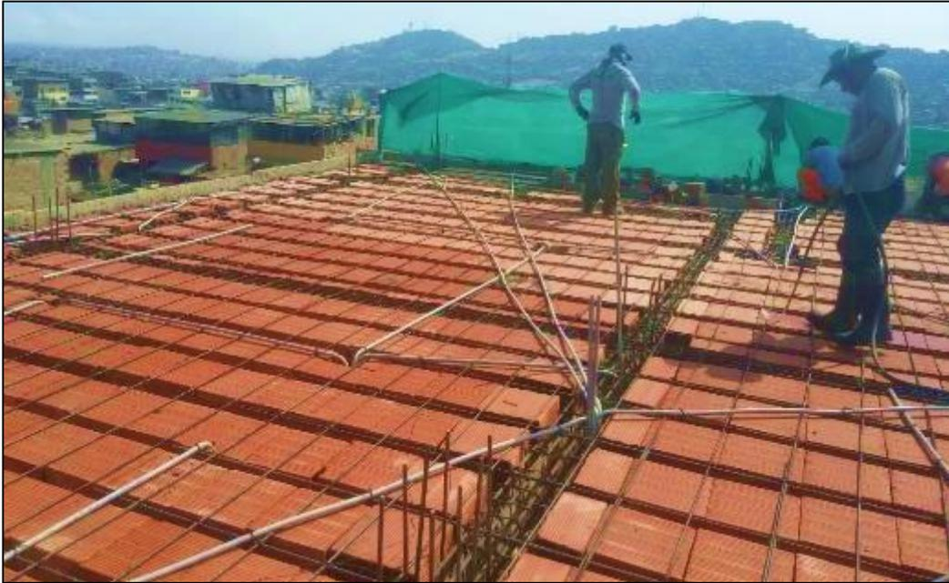
*Figura 19: colocación y humedecimiento de ladrillo de techo*
