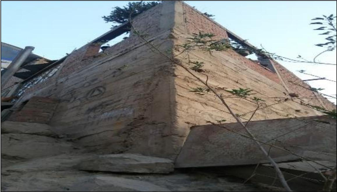
*Imagen 5: se evidencia la falta de dirección técnica se muestra fisuras en el sobre cimientos*
