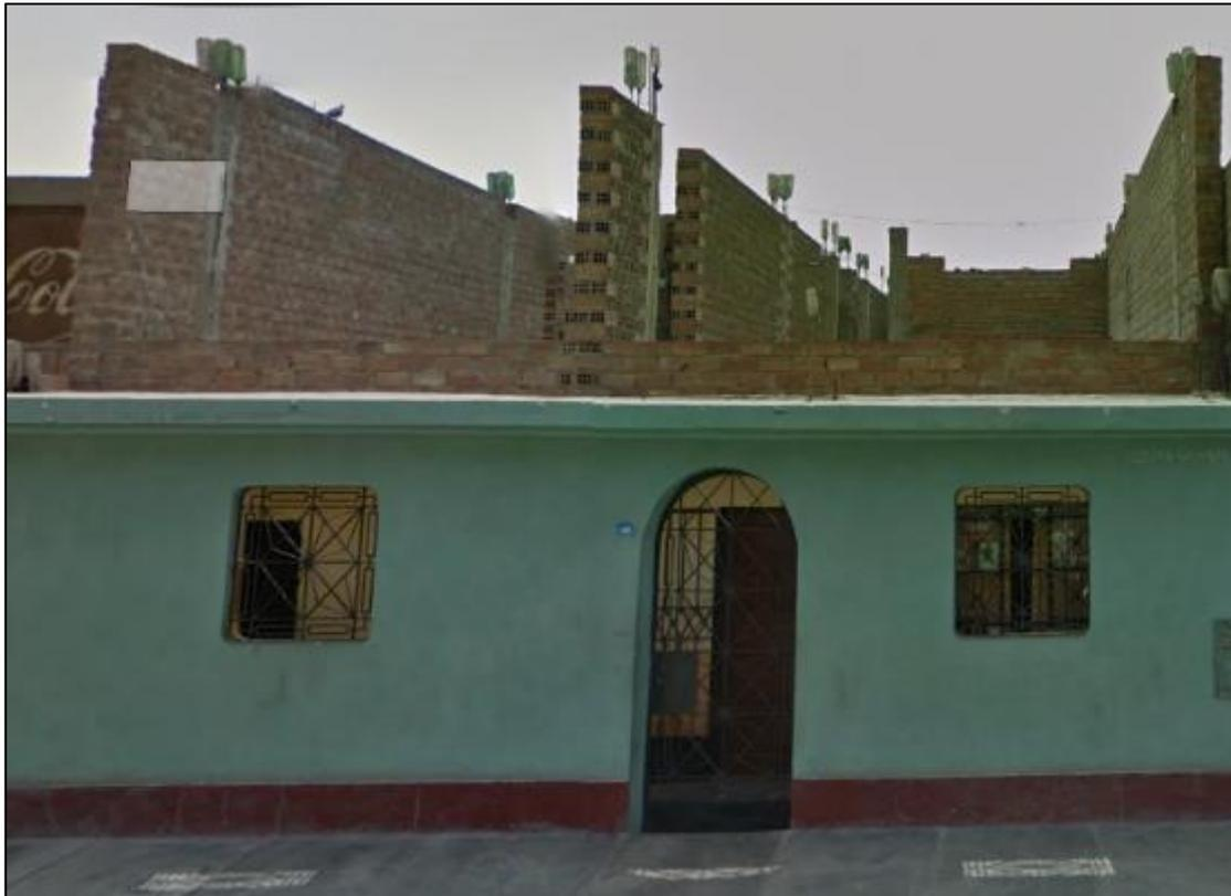
*Figura 20: Asentado de ladrillo en el segundo nivel*
