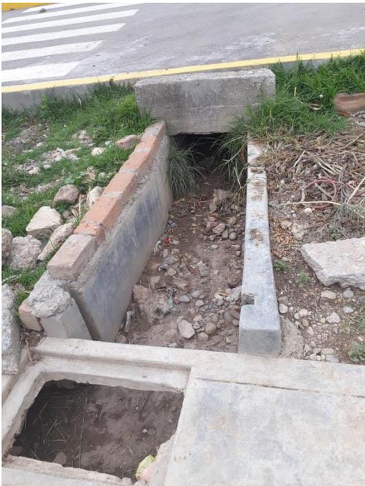
Fotografía 7. Situación actual de las estructuras del canal existente.
