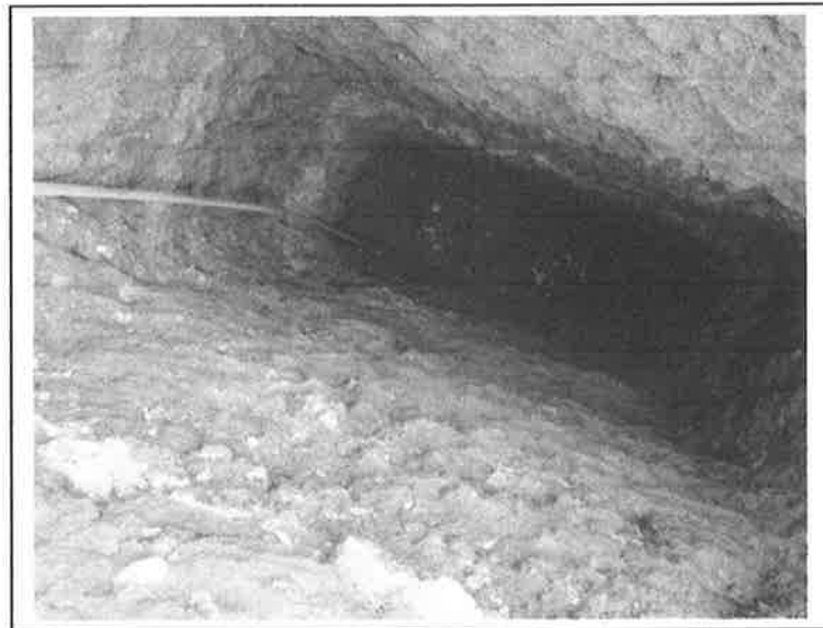
FOTO 02.- PERFIL ESTRATIGRÁFICO DE LA C-1, EN EL PROYECTO “EVALUACIÓN DE LA VULNERABILIDAD SÍSMICA DE LAS VIVIENDAS DEL DISTRITO DE HUAYUCACHI- HUANCAYO- 2016”
