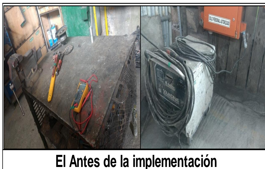
Figura 23: Antes y después del trabajo realizado
