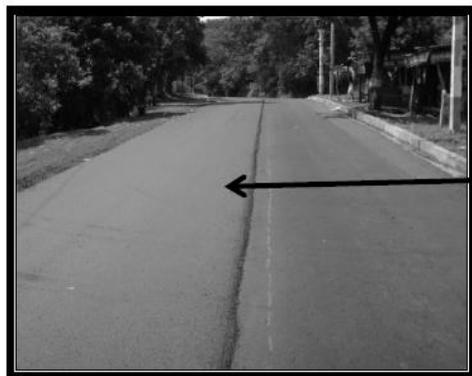
DESPUES: En la imagen se aprecia el proceso de recarpeteo finalizado en un lateral de la calzada.
