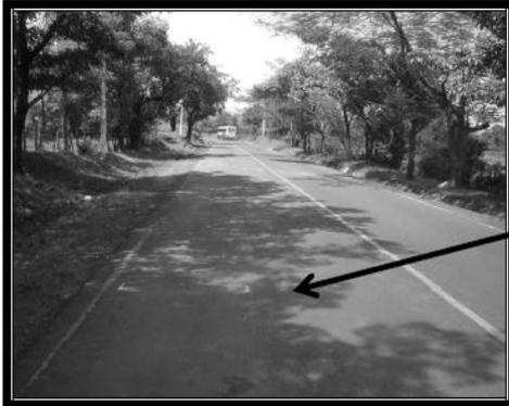
ANTES: La imagen muestra el área afectada en la vía, la cual deberá ser atendida con bacheo profundo, debido a que se observa hundimientos en ella.
