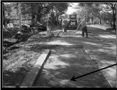
DURANTE: En la fotografía se aprecia el material ya colocado de base quedando pendiente la reposición de la carpeta Asfáltica.
