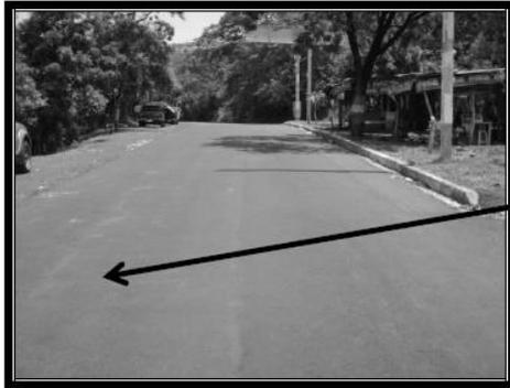
ANTES: La fotografía muestra la capa de rodadura reparada, sellada y bachada, en espera del proceso de recarpeteo.
