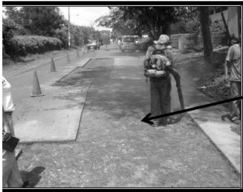
DURANTE: Se observa en la imagen el proceso de limpieza del área a reponer la carpeta de rodadura.
