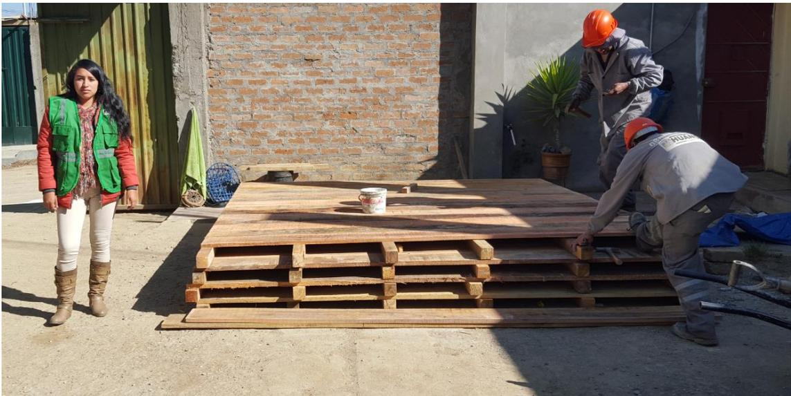
*HABILITACIÓN DE PANELES PARA ENCONFRADO DE PANTALLAS DE MURO DE CONTENCIÓN*
