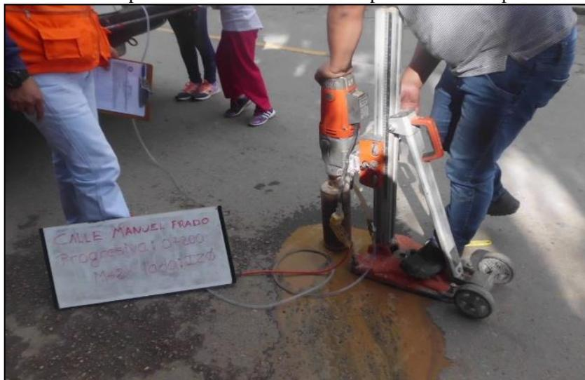
Gráfico N° 10 - finalización de la extracción de diamantinas
