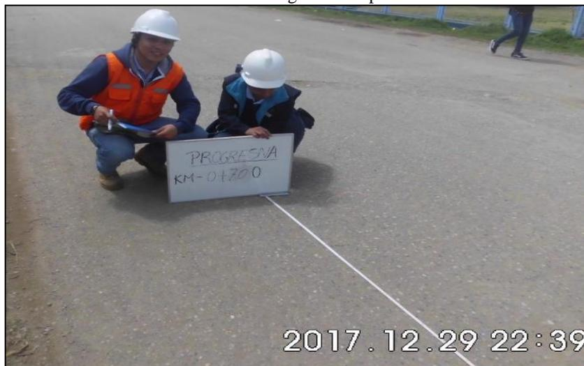
Gráfico N° 25 – medición de la irregularidad de la carpeta asfáltica de ida.
