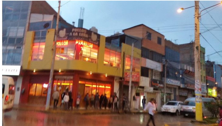
Figura 21. Evidencia fotográfica N° 003
