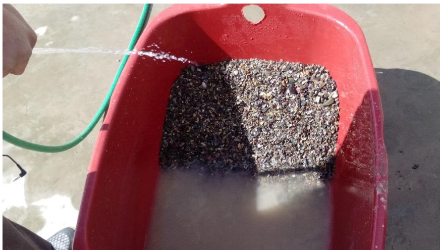
Fotografía 7. Lavado de los agregados para el tanque de filtración.
