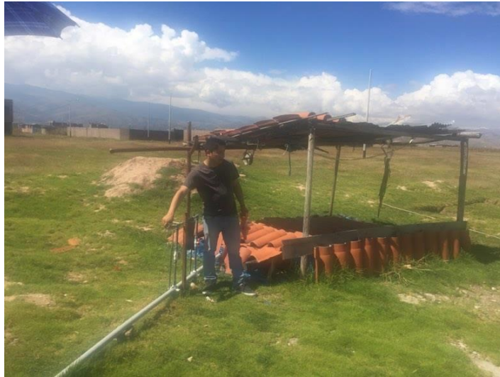
Fotografía 5. Sistema actual de abastecimiento de agua en la urbanización Vista Hermosa.
