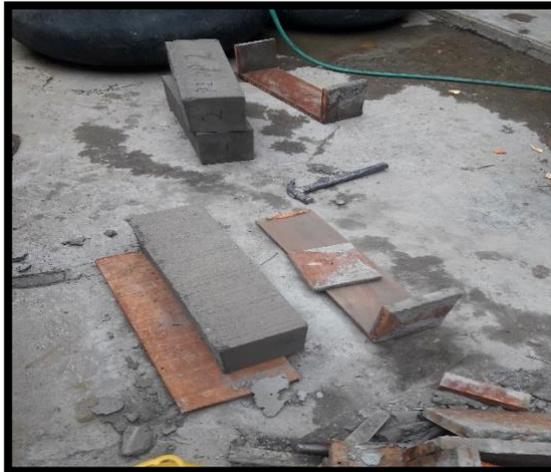
✓ **Desencofrado de probetas.**
