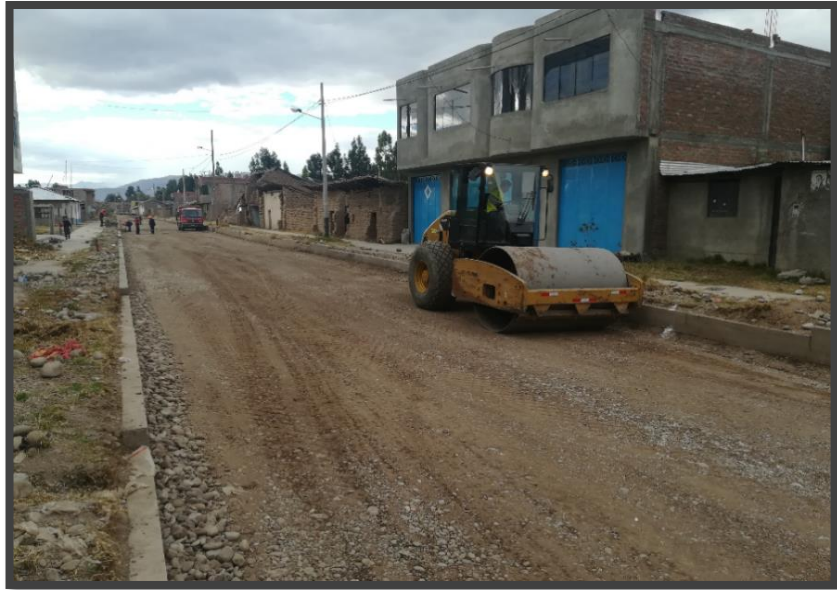
FIGURA N° 14: Compactado a nivel de sub rasante.
