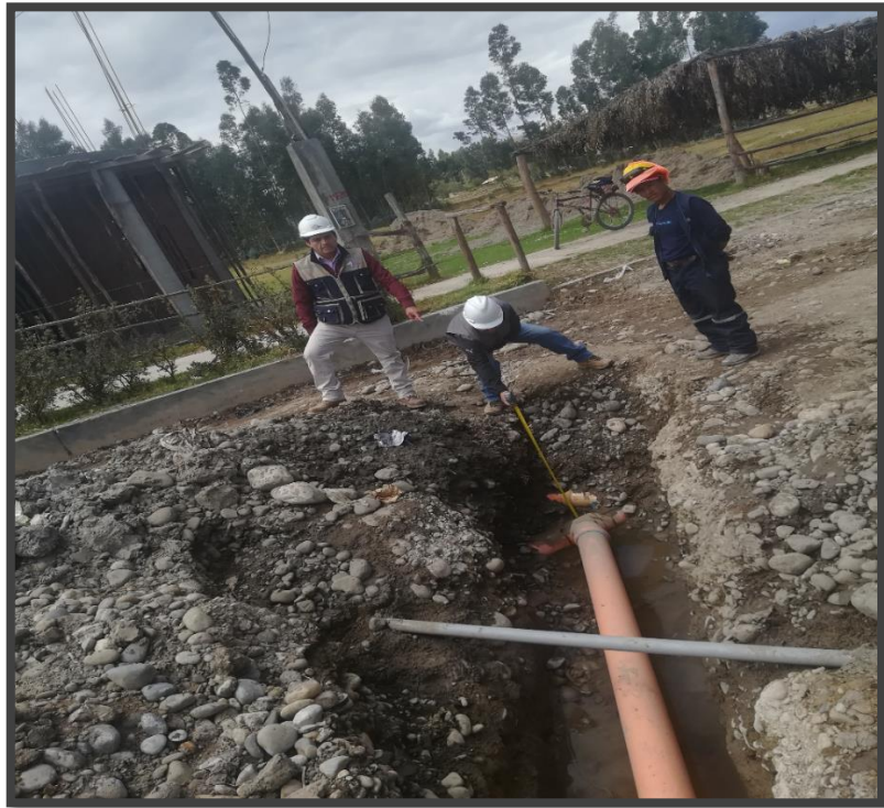
FIGURA N° 18: Profundización de conexiones domiciliarias
