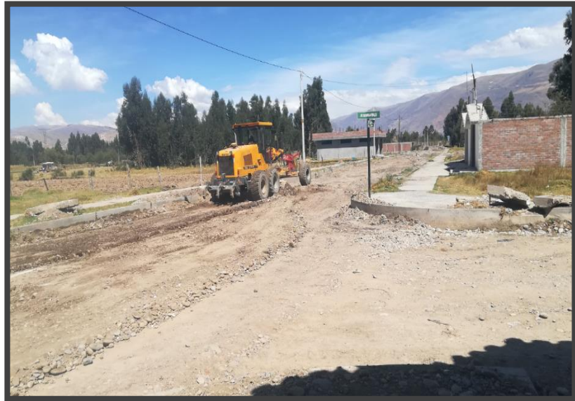
FIGURA N° 30: Trabajo de retiro de material pétreo mayor a 2”.
