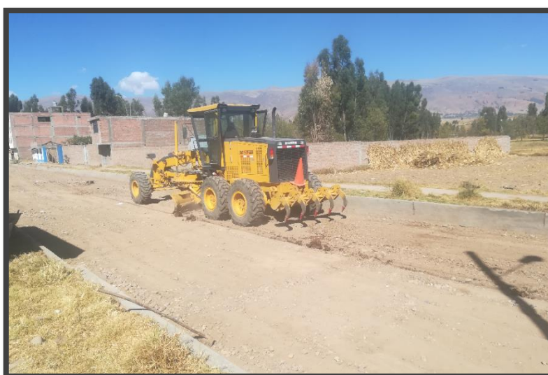
FIGURA N° 09: Escarificado con motoniveladora a 0.15 cm.
