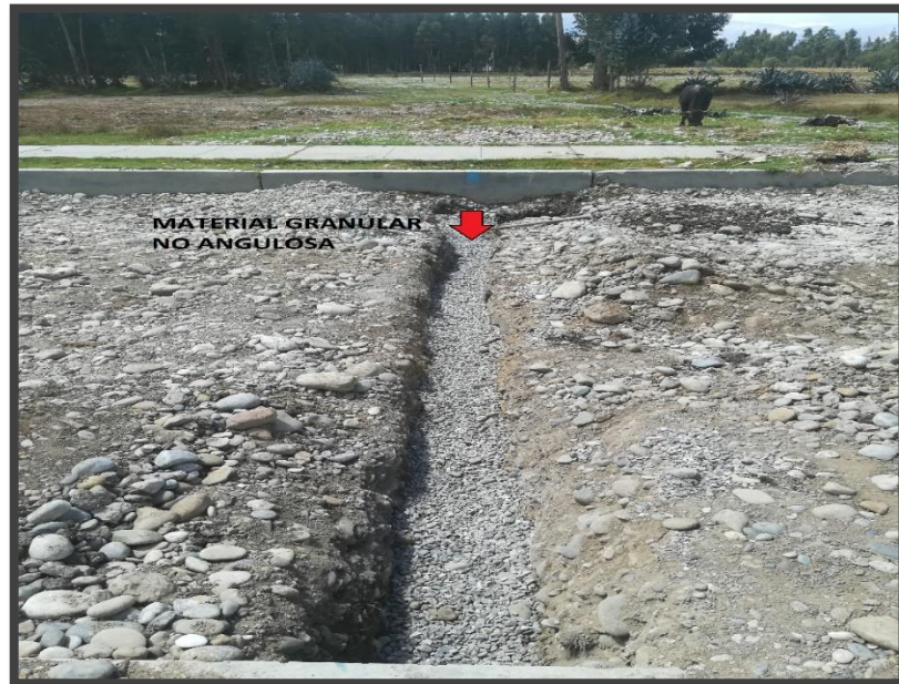
FIGURA N° 27: Trabajos compactado de zanjas.
