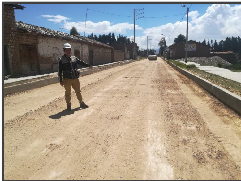
FIGURA N° 33: Plataforma de subrasante conformada.
