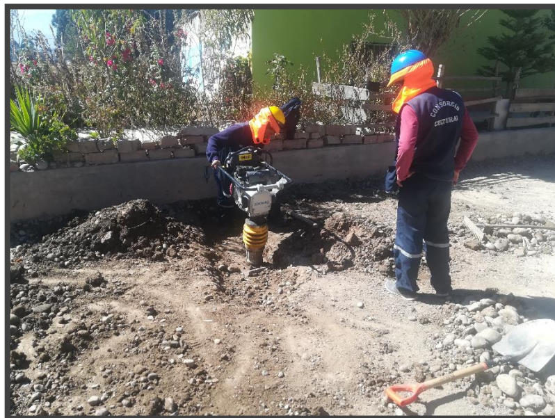
FIGURA N° 27: Trabajos compactado de zanjas.
