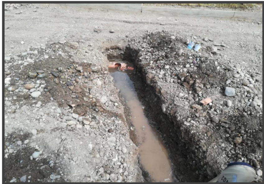
FIGURA N° 17: Excavación en conexiones domiciliarias superficiales existentes.
