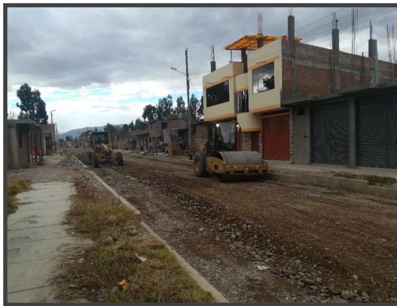
FIGURA N° 10: Colocado y batido de material de préstamo.
