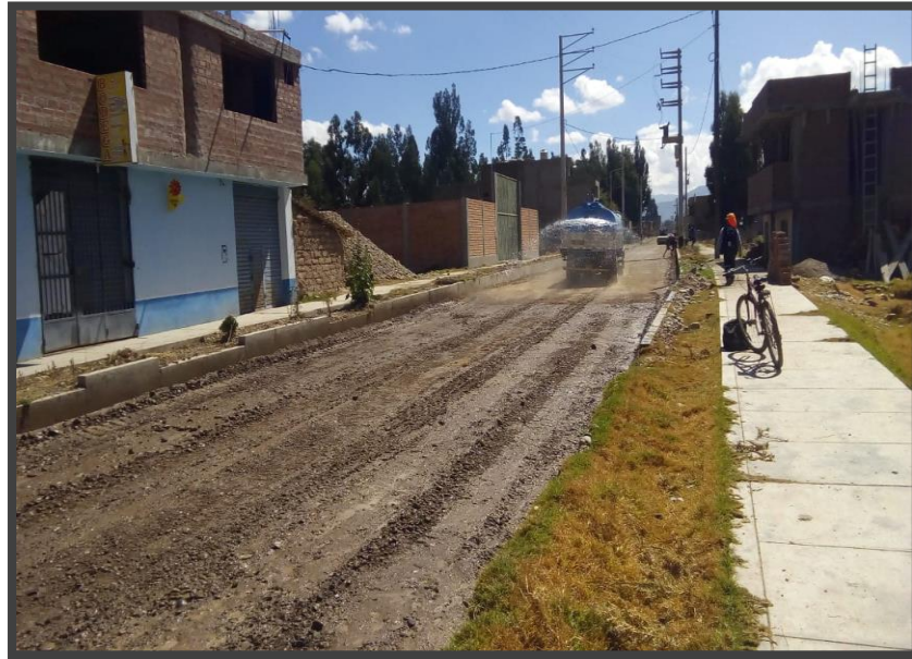
FIGURA N° 12: Riego de material de sub rasante.
