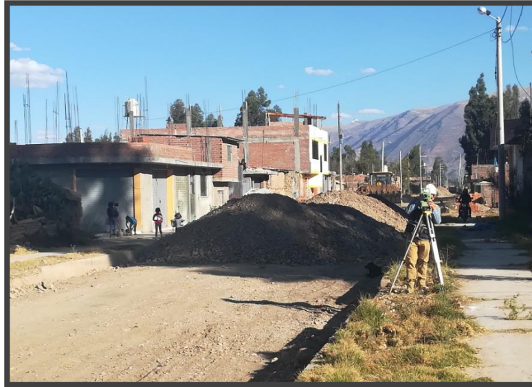
FIGURA N° 08: Control topográfico de corte a nivel de subrasante.
