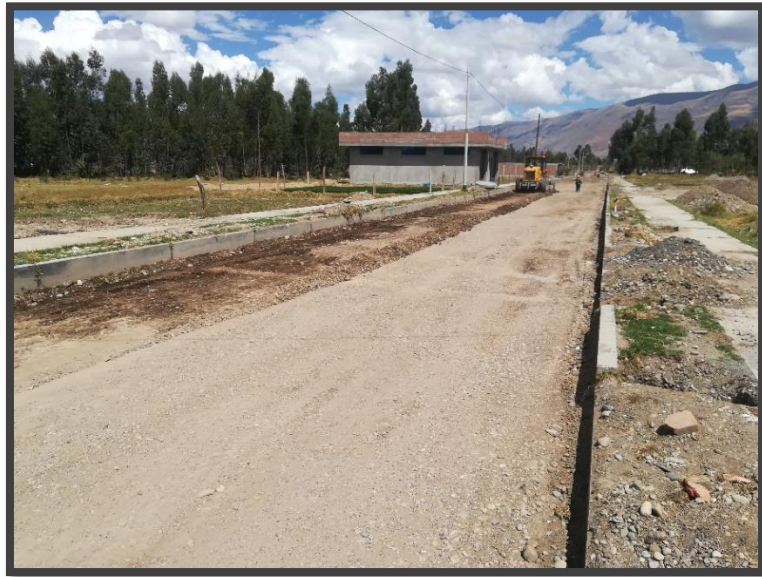
FIGURA N° 31: Conformación de capa a nivel de subrasante.
