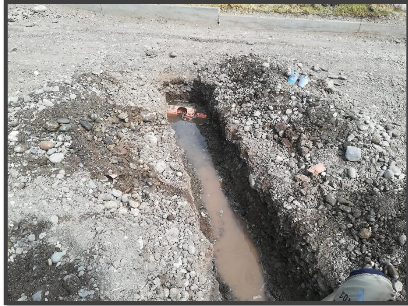
FIGURA N° 06: Verificación de nivel freático a 0.60m
