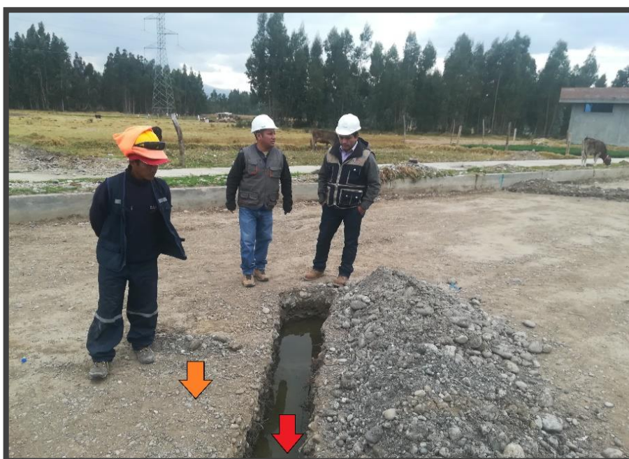
FIGURA N° 21: Control de N.F.S. en zanjas abiertas.
