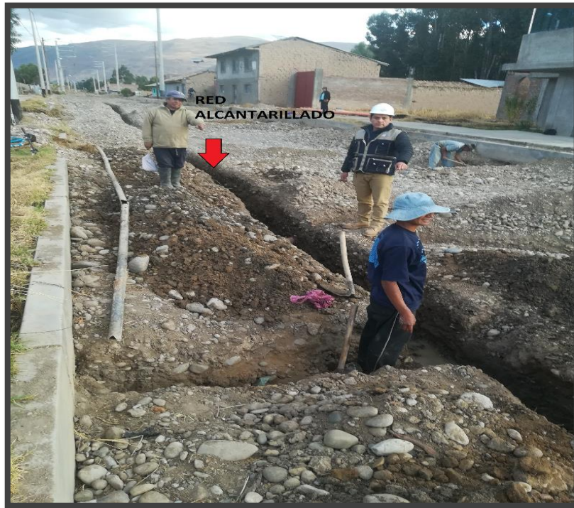
FIGURA N° 23: Excavación, perfilado de conexiones domiciliarias y red troncal de alcantarillado.
