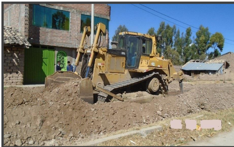
FIGURA N° 07: Corte a nivel de subrasante con tractor oruga.
