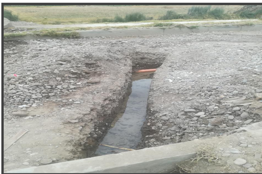
FIGURA N° 21: Control de N.F.S. en zanjas abiertas.
