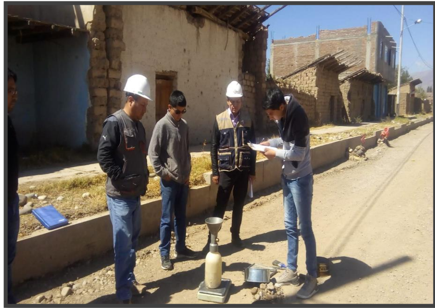
FIGURA N° 16: Pruebas de compactación calculadas Insitu.
