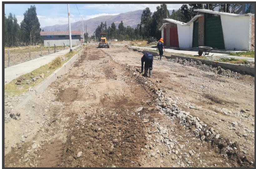
FIGURA N° 30: Trabajo de retiro de material pétreo mayor a 2”.
