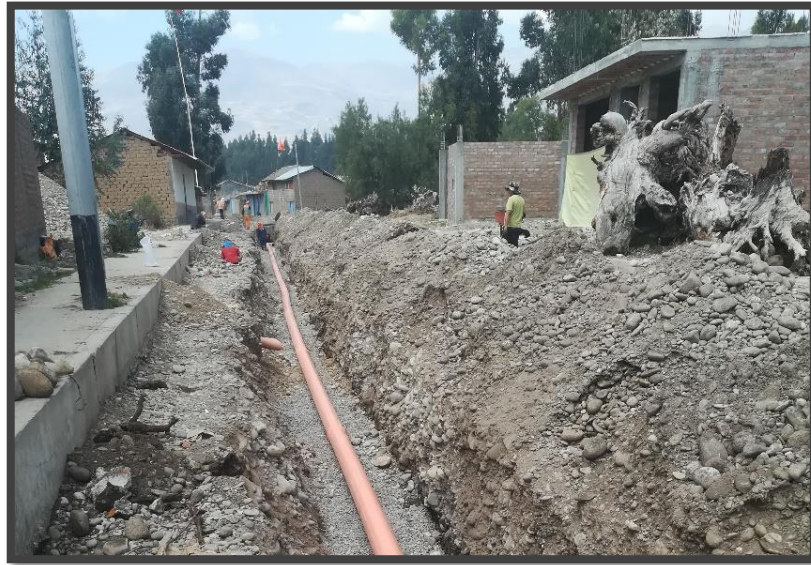
FIGURA N° 25: Colocación de cama de apoyo e instalación de tuberías de 8" en red de alcantarillado.
