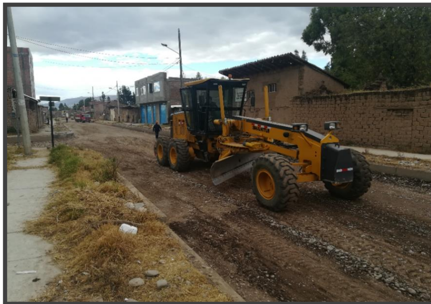
FIGURA N° 13: Extendido y batido de material con motoniveladora.
