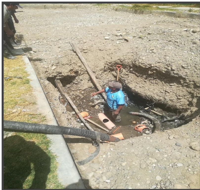
FIGURA N° 24: Utilización de equipos de bombeo.
