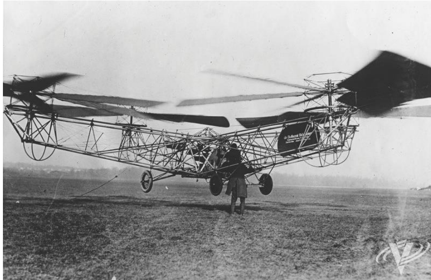
Figura 1.5: Prototipo de Quadrotor De Bothezat, 1923
