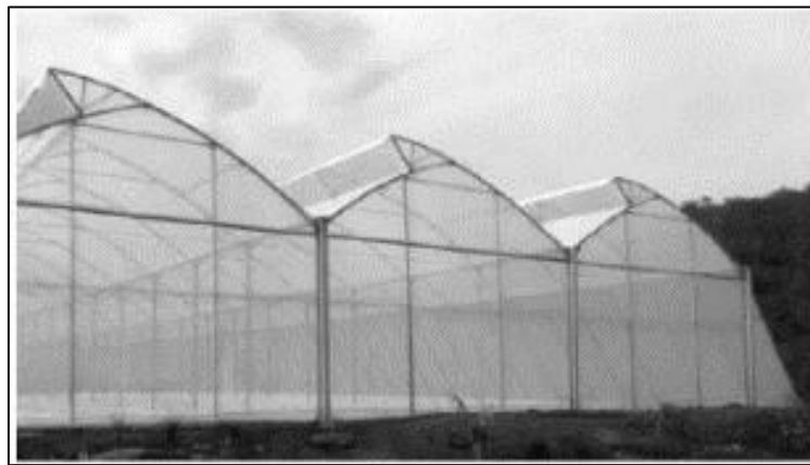
Figura 16. Estructura del invernadero tipo Asimétrico o Inacral.
