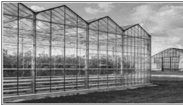
Figura 20. Estructura del invernadero tipo Venlo. Fuente: Recuperado de www.horticultivos.com/agricultura-protegida/invernaderos
