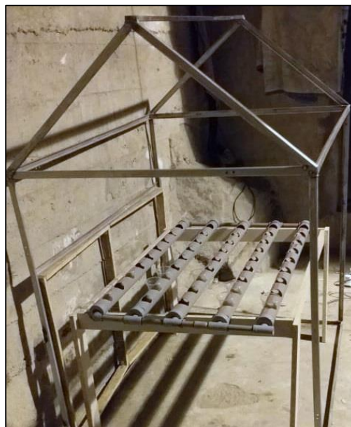
Figura 48. Construcción de la estructura para el invernadero Fuente propia.
