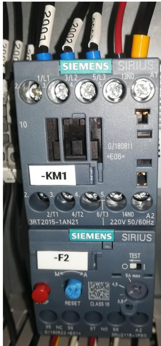
*Figura 68: Circuito de control real del motor de la electrobomba.*
