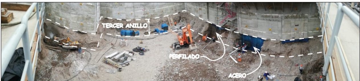
Figura 9: Partidas en ejecución del tercer anillo de muros anclados.
