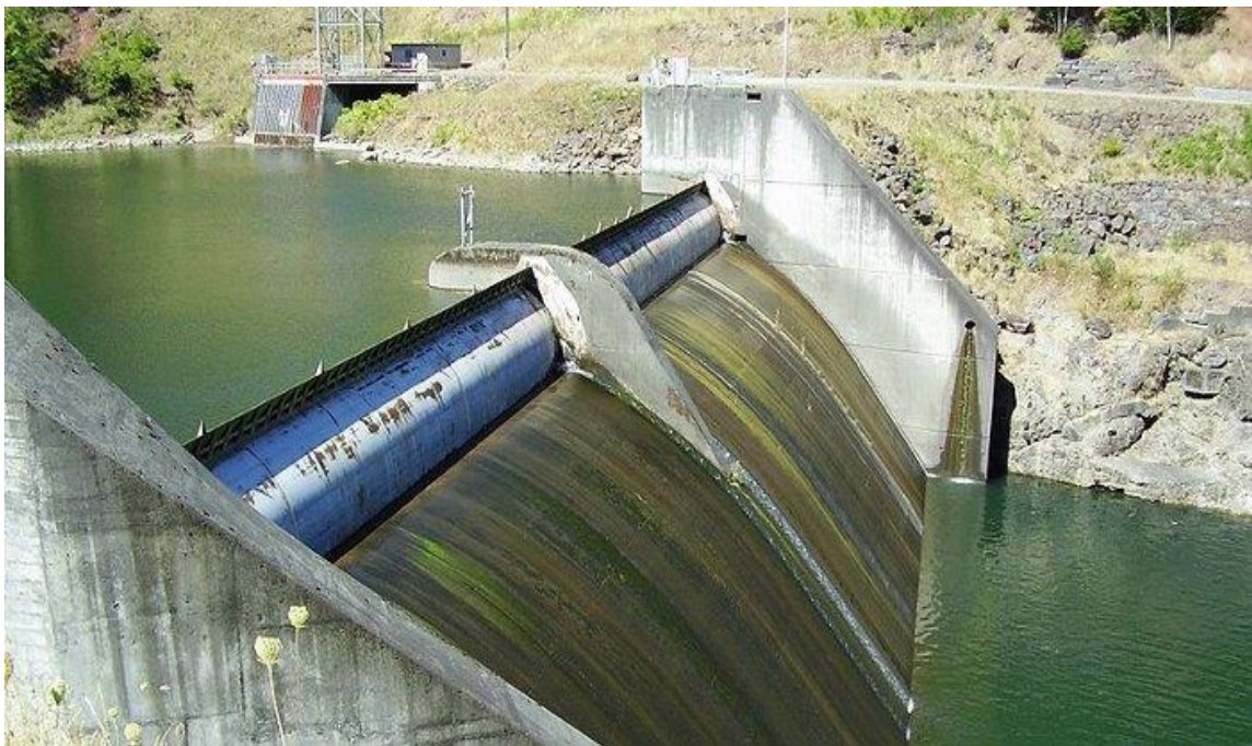
Figura 2.4. Vertedero de la presa Faraday, río Clackamas, Oregón.
