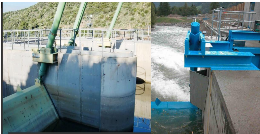
Figura 4.16. Compuerta Clapeta con accionamiento aguas arriba
