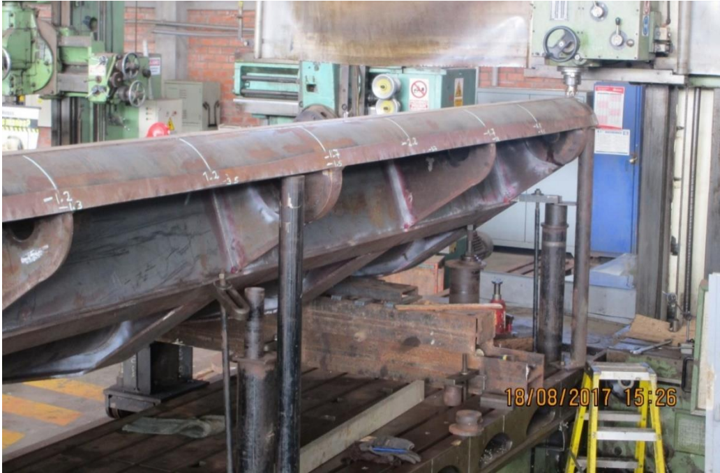
Figura 4.13. Maquinado de platina Inoxidable para asiento de sello instalaciones GCZ ingenieros SAC.
