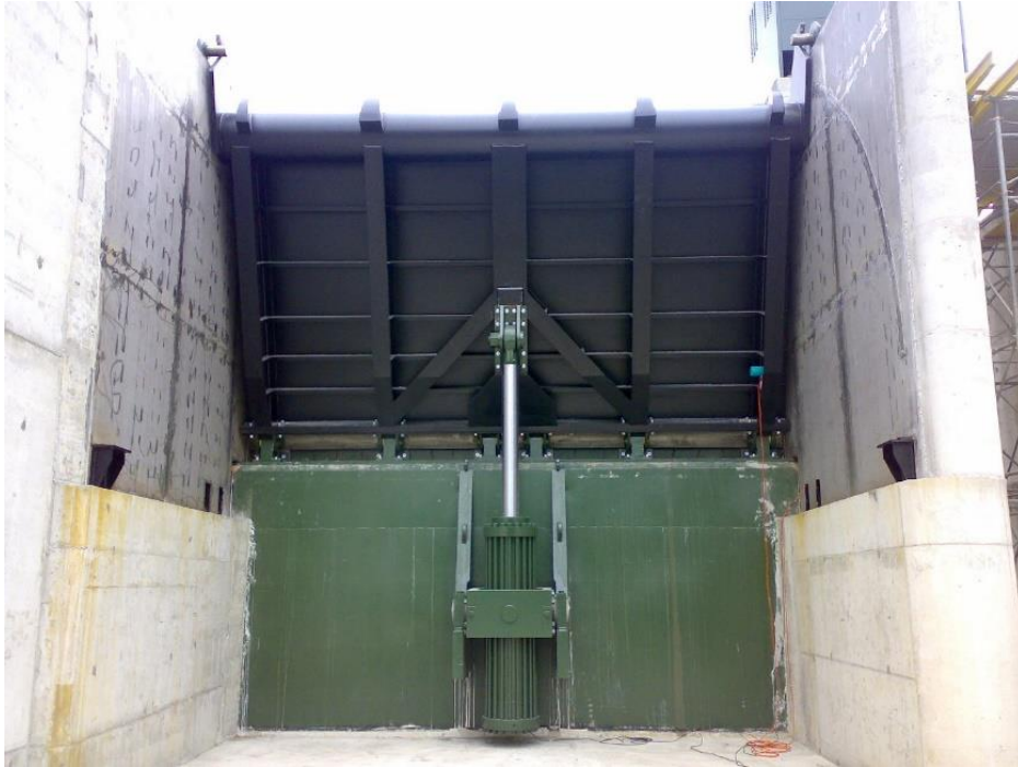
Figura 4.17. Compuerta clapeta con accionamiento aguas abajo
