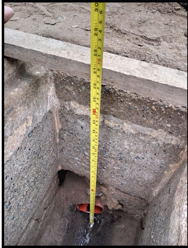
Fotografía 4 Medición de la variación de pendiente en las cajas de registro.
