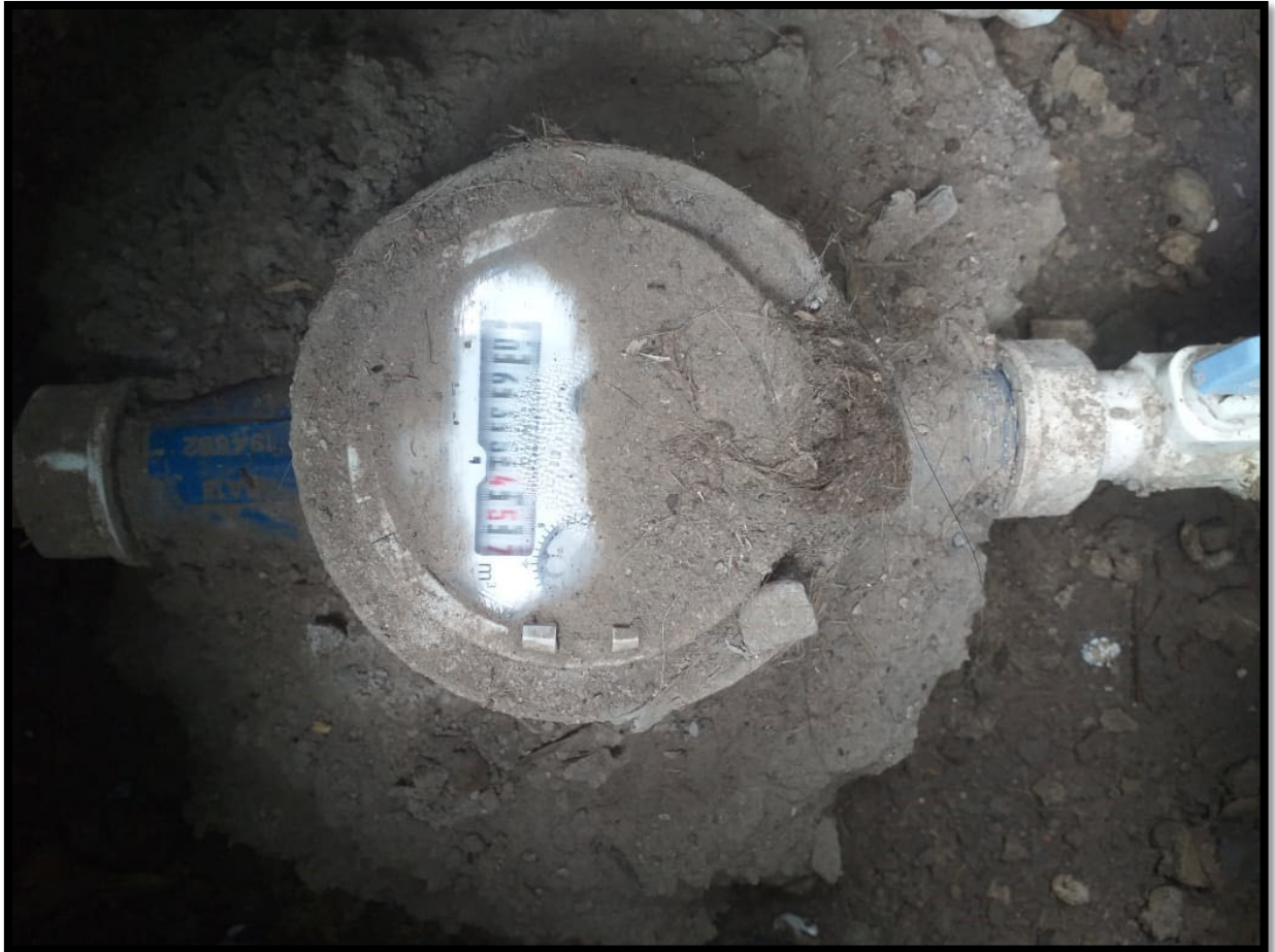
Fotografía 3 Toma de datos del caudal de ingreso de agua potable en la vivienda.
