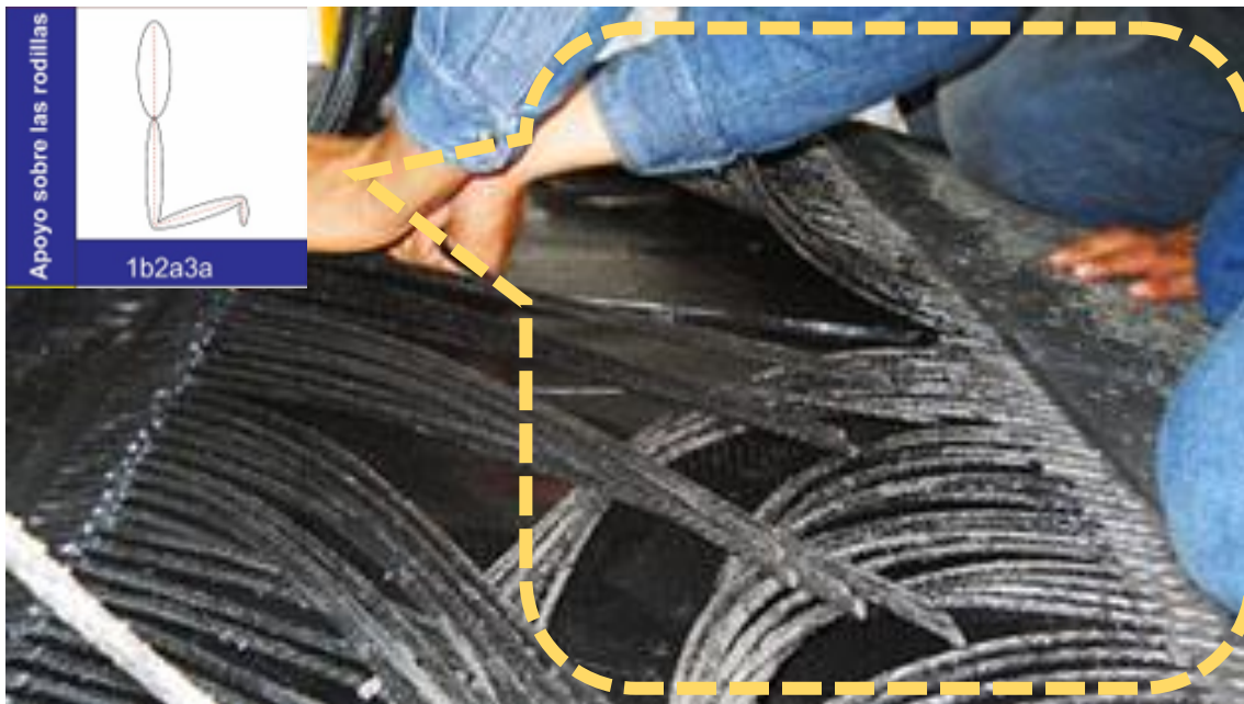
Figura 11. Preparado de las partes para vulcanizado
