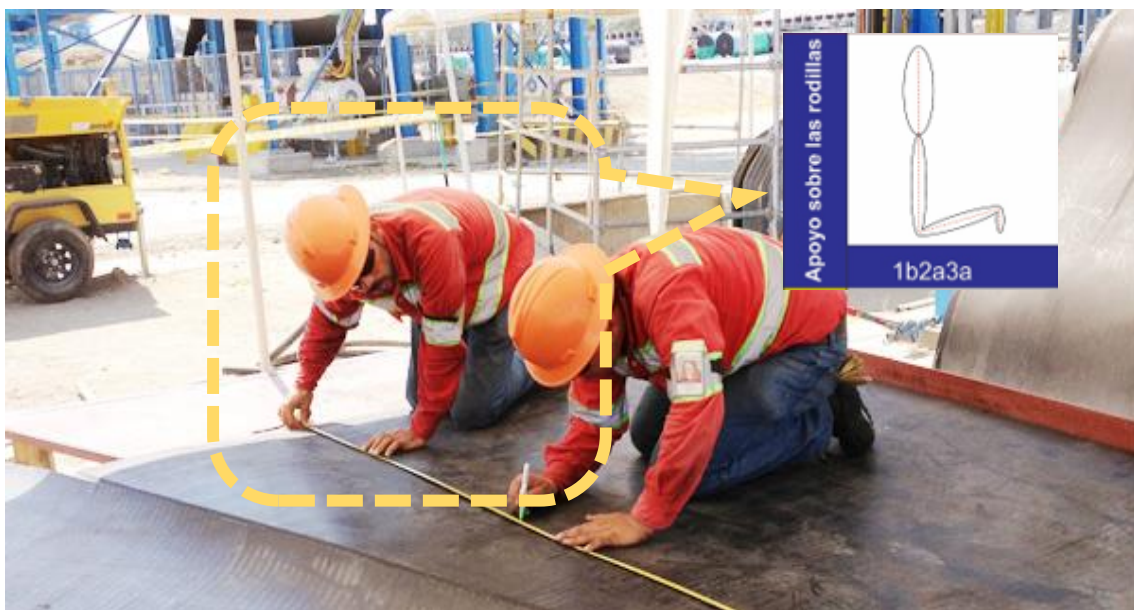
Figura 10. Marcado sobre la nueva faja
