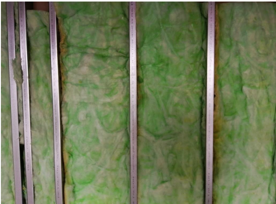
Estructura metálica de pared divisoria
