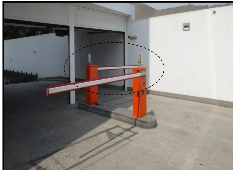
Figura 27. Sistema de identificación por radiofrecuencia (RFID) para autos, causante de las interferencias.
