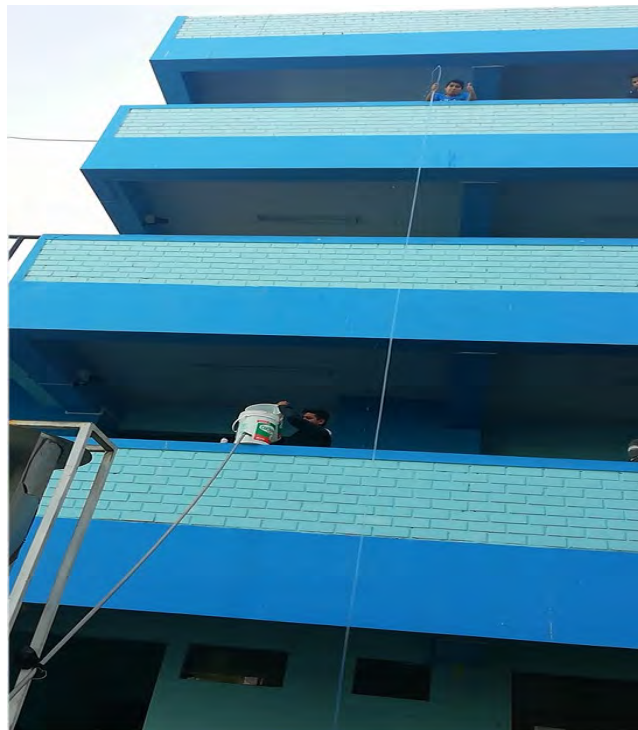
Figura 15. Agua bombeada alcanzando los 15 m sobre el nivel de la bomba.
