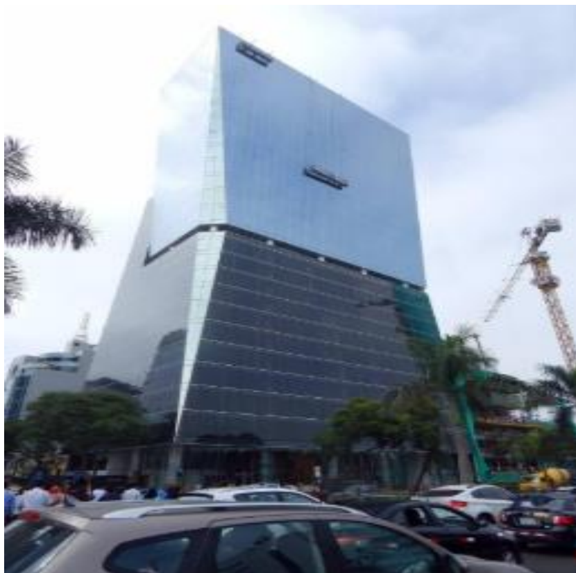
Figura 27. Edificio de WeWork
