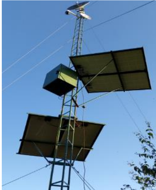
Figura 53: Sistema de energía fotovoltaico.
