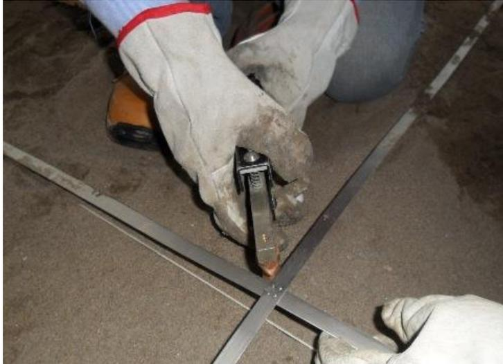
Figura 25: Soldadura entre barras conductoras
