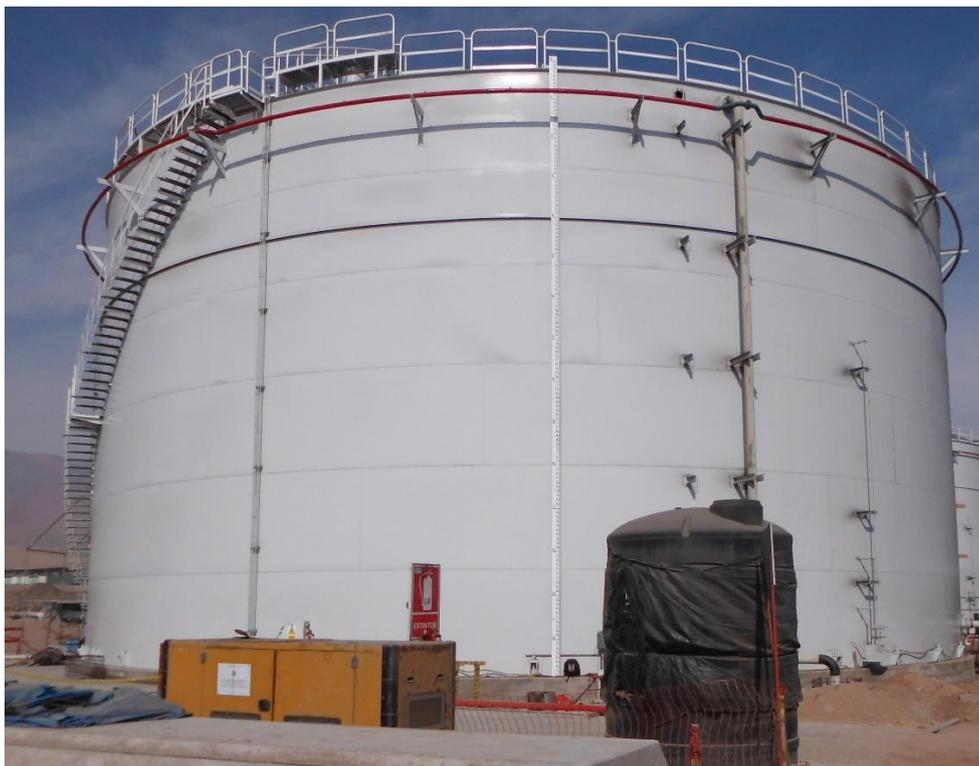
Figura 11: Tanque de almacenamiento del diésel no tratado.
