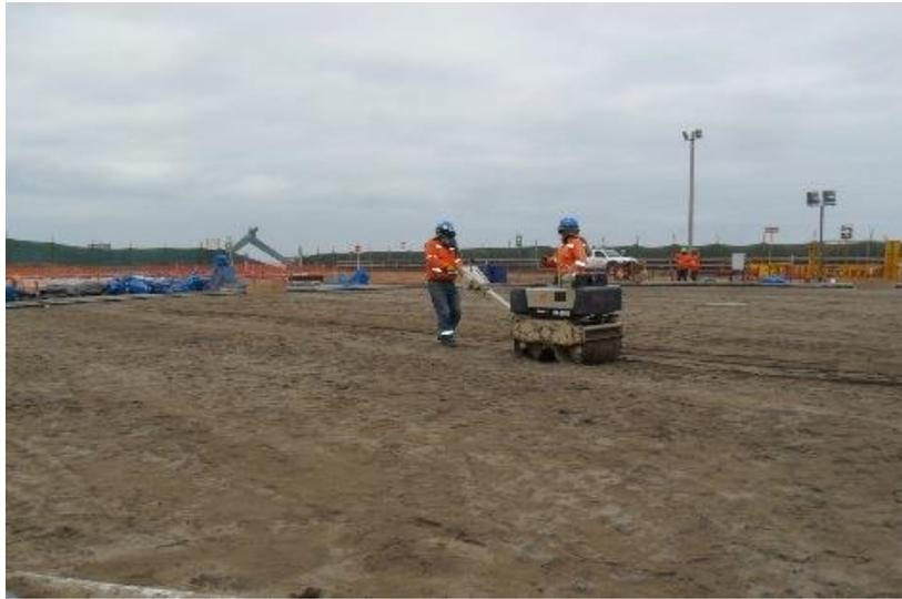
Figura 28: Arena de relleno compactada
