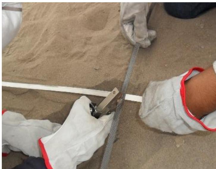
Figura 26: Soldadura de barra conductora y cinta anódica
