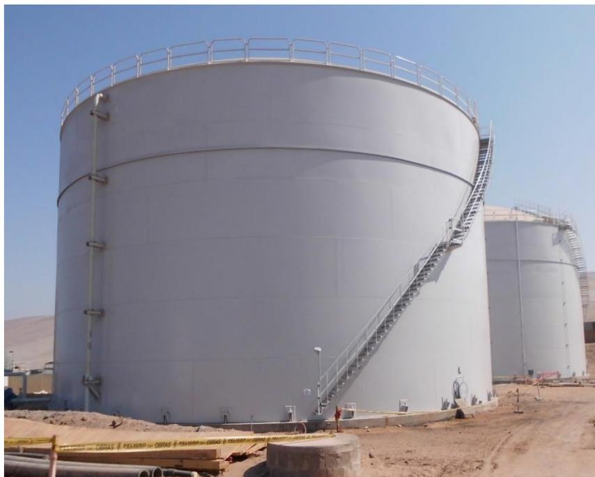
Figura 12: Tanque de almacenamiento del agua desmineralizada
