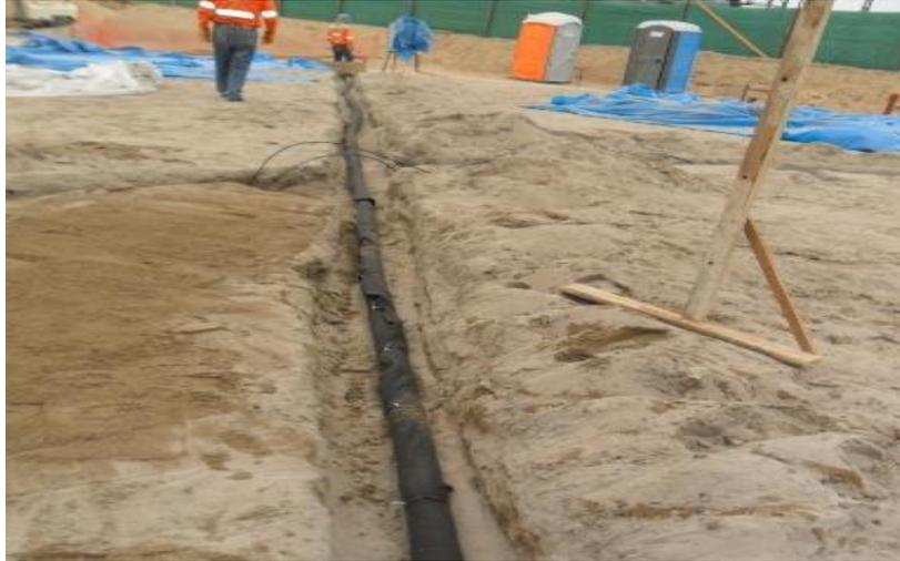
Figura 24: Instalación de tuberías
