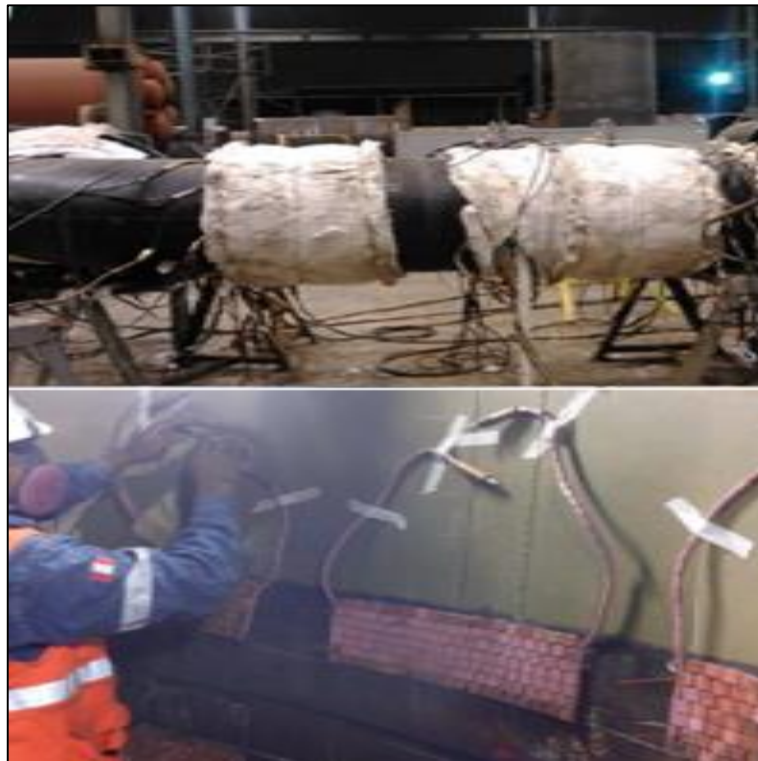
Figura N° 47 END – Tratamiento térmico – Rayos X.
