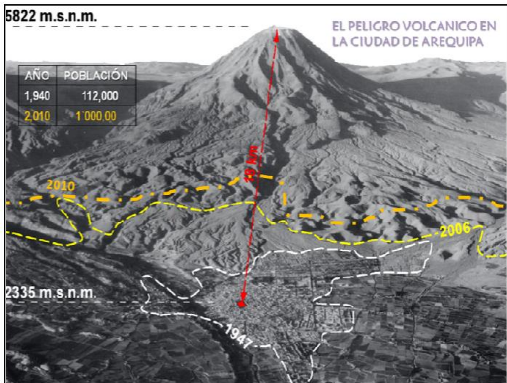
Fig. 10. Expansión urbana de la ciudad de Arequipa, nótese esta tendencia hacia el volcán Misti. En blanco expansión urbana en el año 1947, en amarillo al 2006 y en naranja al 2010.
