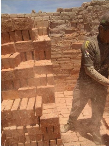
Imagen 03: Descarga del ladrillo cocido
