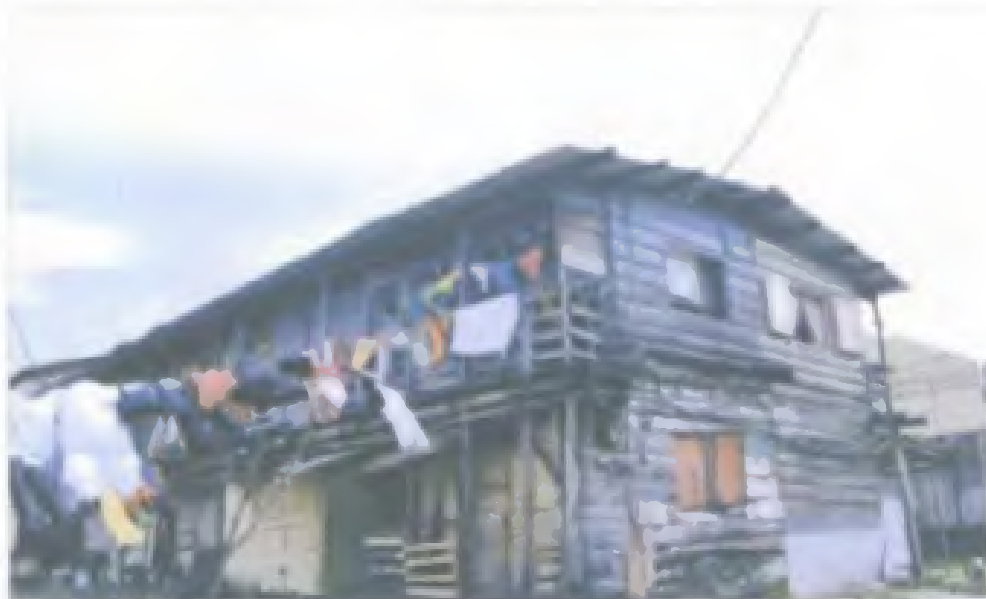
Figura N°29 Vivienda Tipo Condenada
