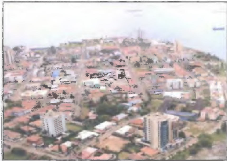
FIGURA N°4 VISTA PANORÁMICA DE LA CIUDAD DE COLÓN DONDE SE OBSERVAN GRANDES CONDOMINIOS EN EL PASEO GORGAS
