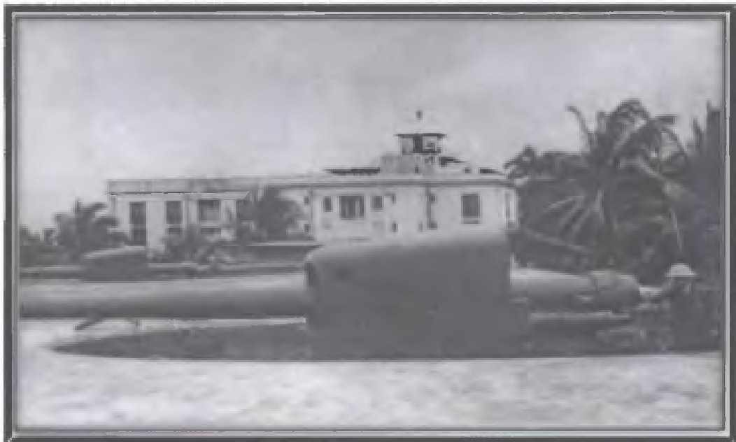
Figura N°41 FUERTE LESSEPS EN LA CIUDAD DE COLÓN (BATERÍA MORGAN) EN 1923
