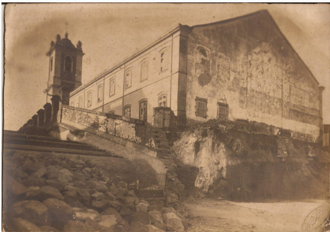
Figura 6: Fundos da igreja matriz após a demolição da nave e traslado do altar-mor para o arco-cruzeiro (percebe-se a cicatriz na alvenaria), c.1920
