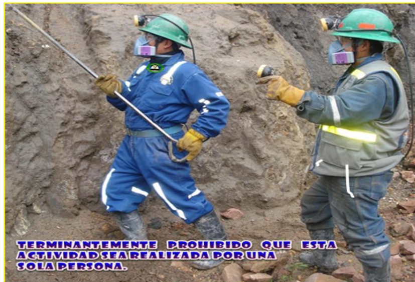
Figura N°24. Desatado de rocas en forma manual
