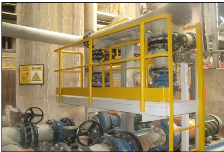
Figura 32. Después del levantamiento de observaciones
