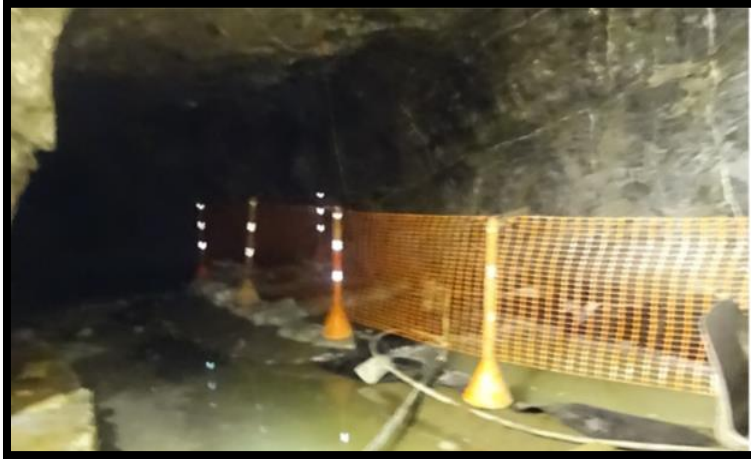
Figura 75. Señalización y aislamiento del área
