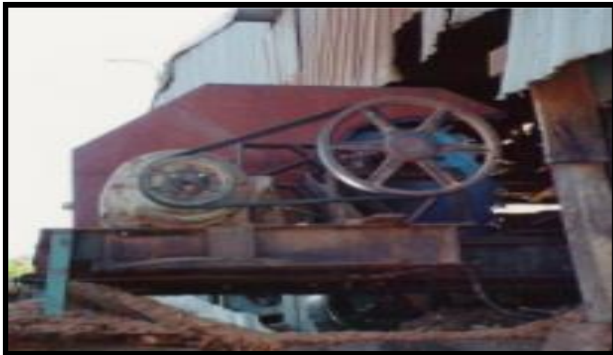
Figura 39. Instalación de equipo
