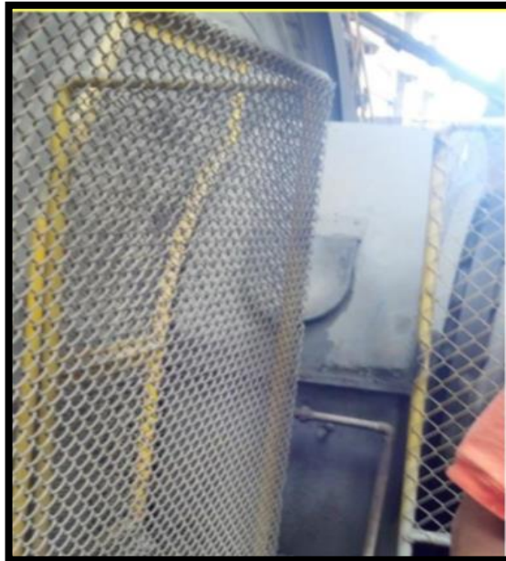
Figura 76. Guardas de protección de un equipo en funcionamiento
