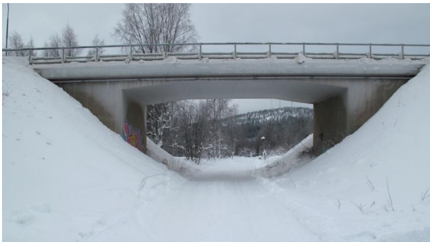
Bild 15: Järnvägstunneln med Övertorneå i ryggen (Tove Olson 2021)
