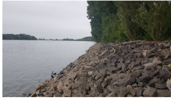
Abbildung 4-2: Steinschüttung zur Ufersicherung nördlich des Untersuchungsgebietes (ab Rhein-km 476,5) als Vergleich für vorherigen Zustand vieler Uferbereich im Untersuchungsgebiet 12
