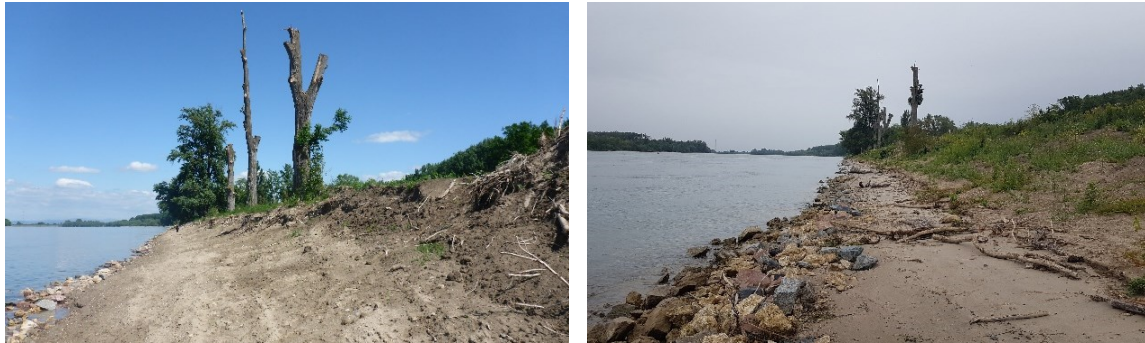
Abbildung 4-4: Erste Entwicklungen der Uferböschung bei Rhein-km 476,0: ein Vergleich des Zustands kurz nach der Baumaßnahme (links, BfG 12.05.2020) und zwei Monate später (rechts, eigene Aufnahme 08.07.2020), Blick nach Norden
