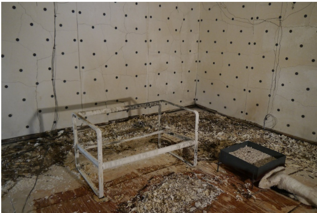
Abbildung 27 Brandraum nach dem Brandversuch
