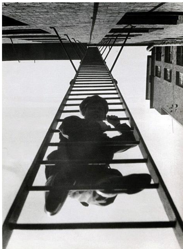
Escada de incêndio (1925)
