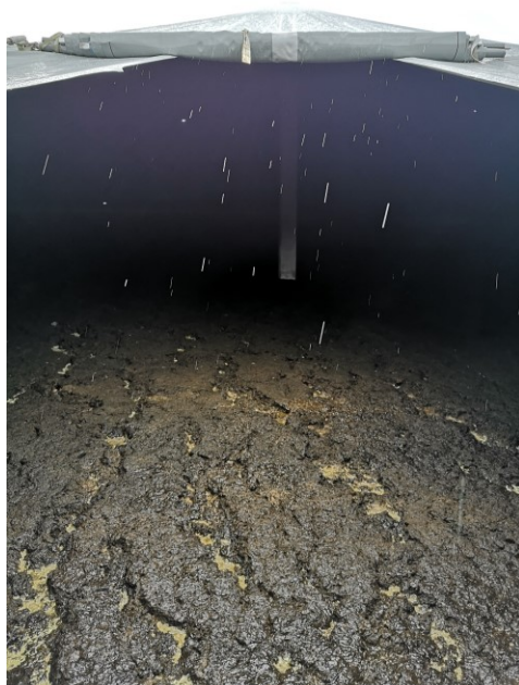
Bilde 2. Eksempel på skorpe i kum med tett tak og tilførsel av gjødsel i bunnen av kummen. Foto Peggy Haugnes, NORSØK
