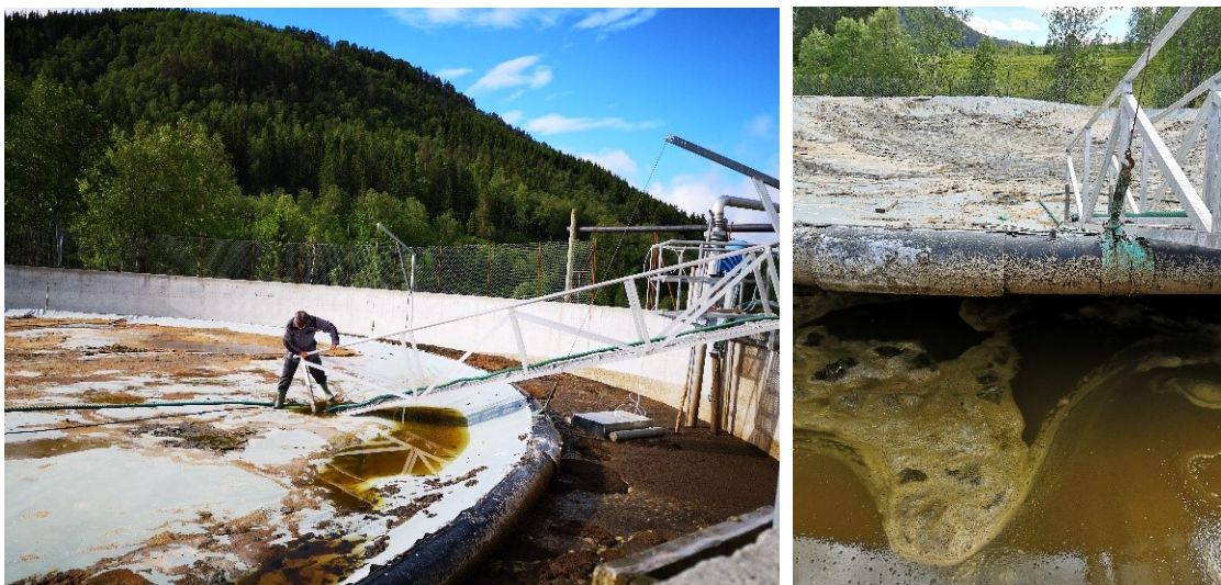
Bilde 11. Plany-flytedekke på kum C. Flytedekket er løftet opp og røring pågår på bildet til høyre. Foto Peggy Haugnes og Martha Ebbesvik, NORSØK
